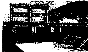
(ค) ประตูระบายน้ำ
