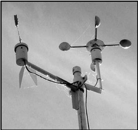
รูปที่ 4-2 ตัวอย่างเครื่องมือวัดความเร็วลมที่ติดตั้งบนสถานี
