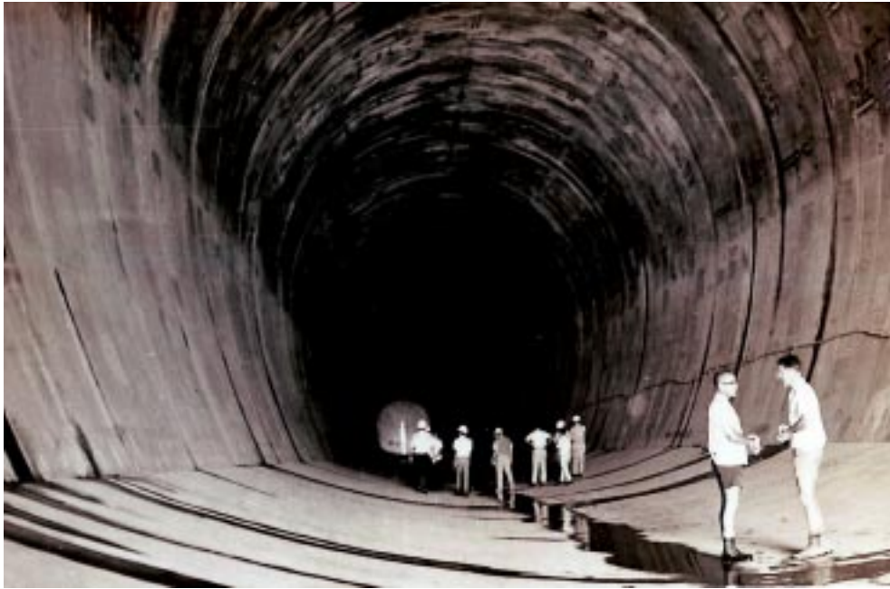
อุโมงค์คั่นน้ำ (และระบายน้ำล้น) ของเขื่อนภูมิพล
