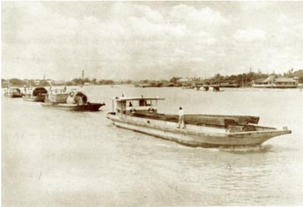
เรือขนาด ๑๐๐ ตัน สร้างในโรงงานของกรมชลประทาน ชนเครื่องอุปกรณ์ไปใช้ในงานก่อสร้างเขื่อนภูมิพล
