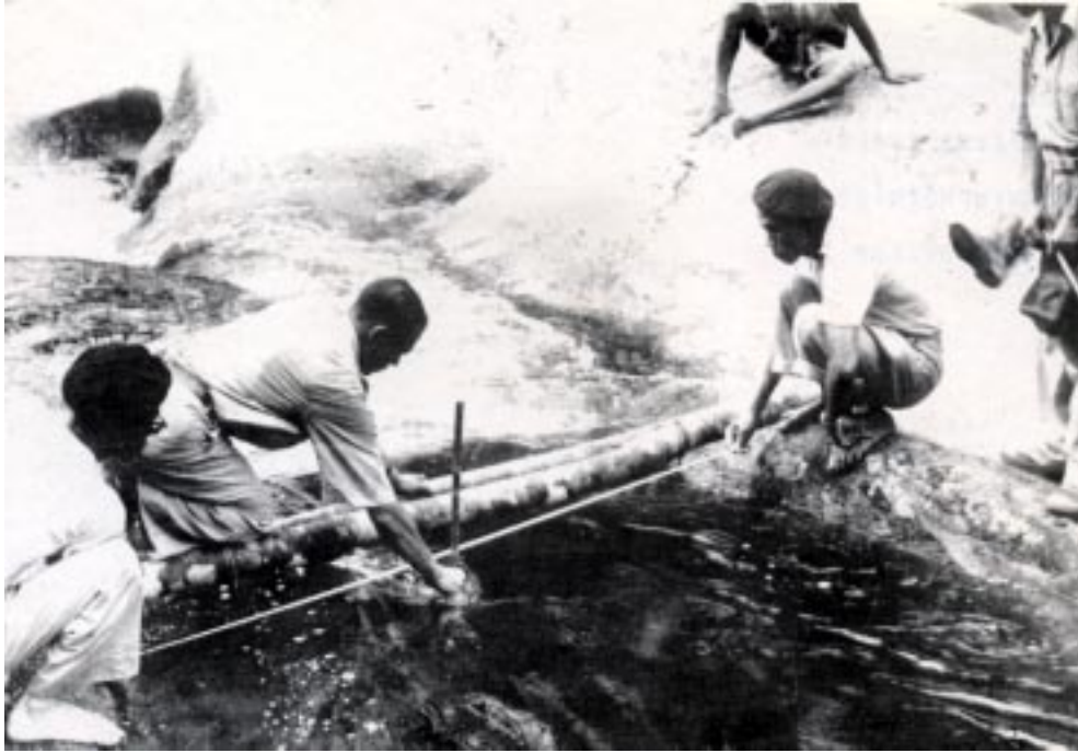
การวัดปริมาณน้ำโดยประมาณ ในการสำรวจตรวจสอบเบื้องต้น
