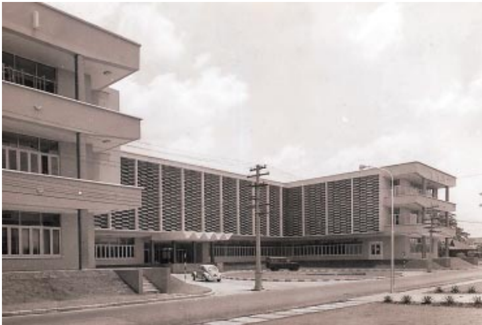
อาคาร ที่ทำงาน กรมชลประทาน สามเสน พ.ศ. ๒๕๐๗
