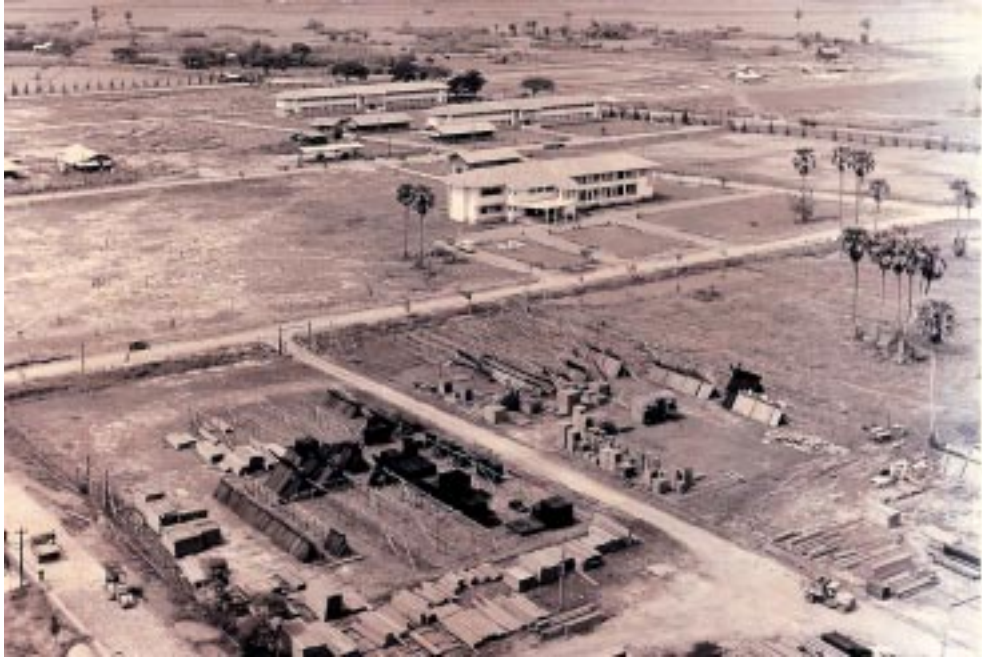
ภาพถ่ายทางอากาศ ของกรมชลประทาน ปากเกร็ด ขณะเริ่มก่อสร้าง และอาคารเรียนหลังแรกของวิทยาลัยการชลประทาน ที่ปากเกร็ด พ.ศ. ๒๔๙๖
