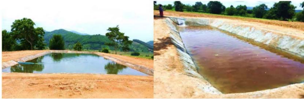
รูปที่ 3-12 สระขอยซีเมนต์ (Soil Cement Pool)
