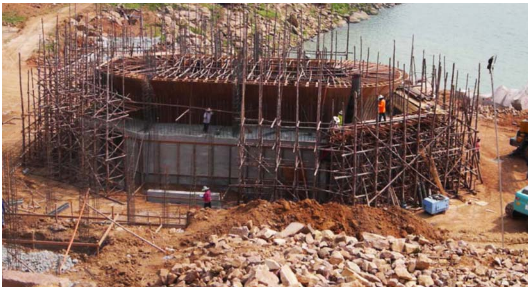
รูปที่ 3-53 งานตั้งแบบและเหล็กเสริม
