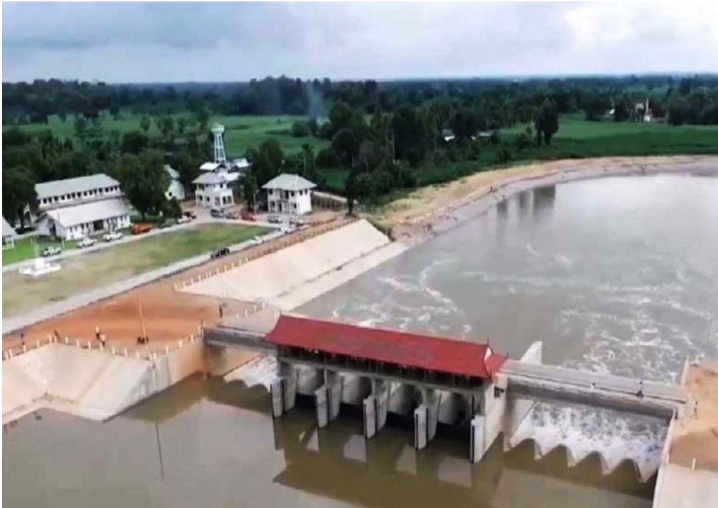
รูปที่ 3-32 โครงการดำเนินการก่อสร้าง ปี พ.ศ. 2557 และแล้วเสร็จปี พ.ศ. 2560
