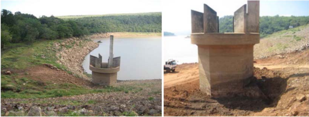
รูปที่ 3-48 งานตัดคอนกรีตอาคาร Morning Glory ด้วยโซ่ (Wire Saw)
