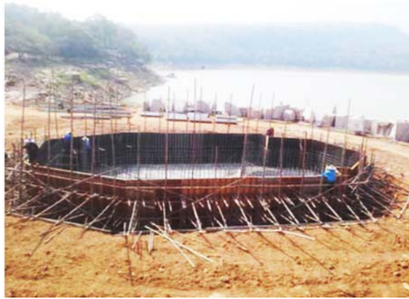
รูปที่ 3-51 งานไม้แบบ
