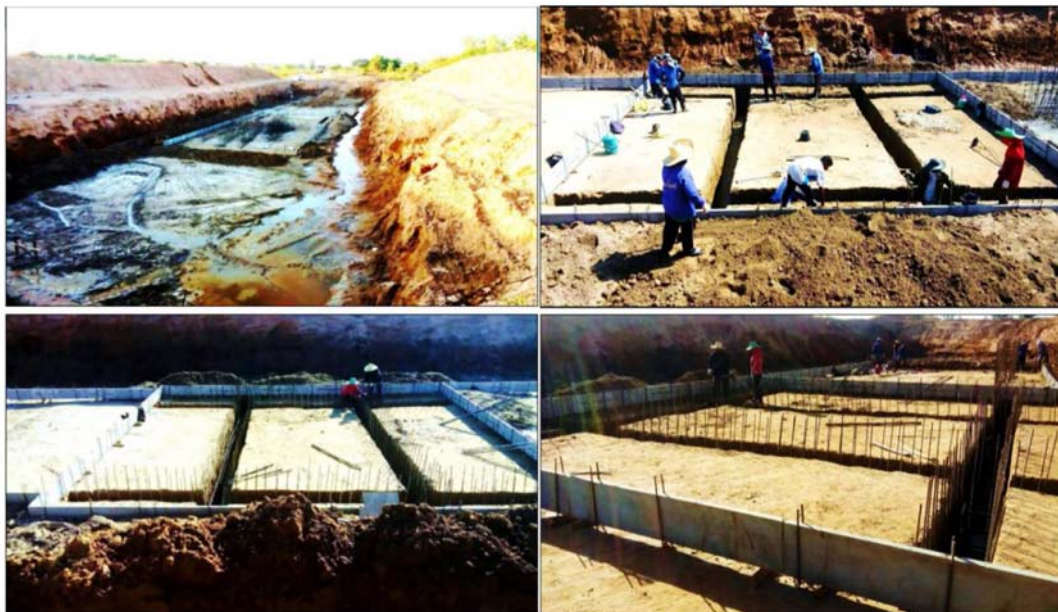
รูปที่ 3-10 การทำชอยซีเมนต์ฐานรากสภาพพื้นที่เป็นดินทราย
