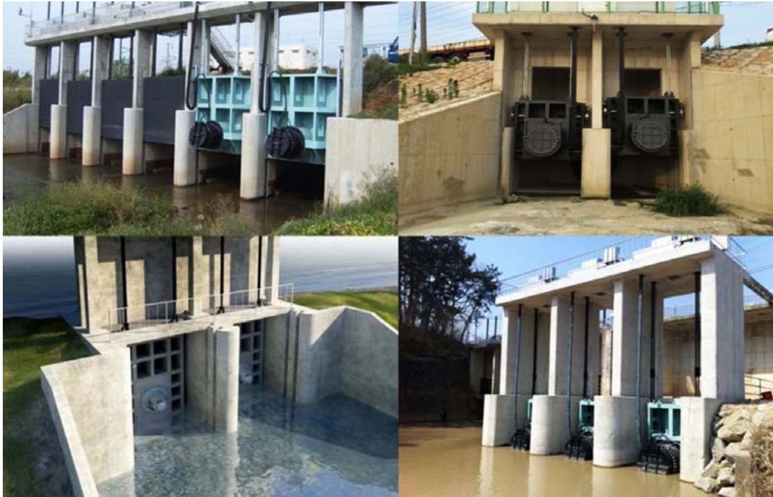
รูปที่ 3-19 โครงการตัวอย่างการติดตั้ง Gate Pumping Station
