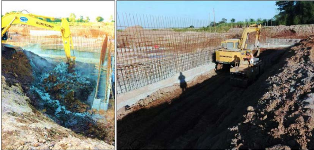
รูปที่ 3-11 การทำขอยซีเมนต์และบดอัดขอยซีเมนต์กำแพงข้าง
