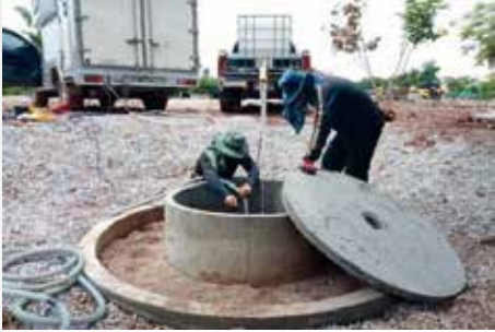
(1) เติมน้ำลงไปบ่อเติมน้ำใต้ดิน เพื่อทำการล้างบ่อ
