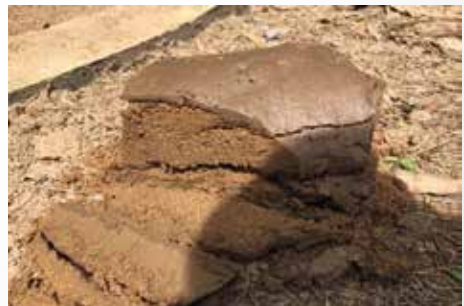
(4) เก็บตะกอนที่อุดตันภายใน บ่อเติมน้ำใต้ดิน
