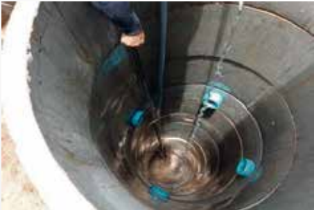
(1) เติมน้ำลงไปบ่อเติมน้ำใต้ดิน เพื่อทำการล้างบ่อ
