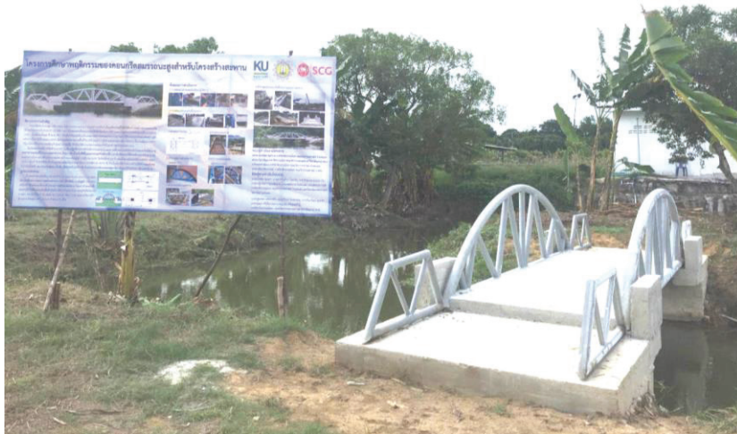
รูปที่ 8-20 แผ่นพื้นเป็นตัวอย่างการกระจายน้ำหนักบรรทุกคงที่ของสะพาน [7]
