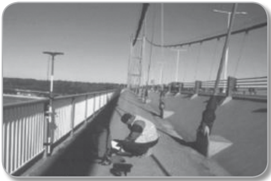
ภาพที่ 5.8 การตรวจจัดการเคลื่อนตัวของสะพานด้วย GPS (Ashkenazi et al., 1997)
