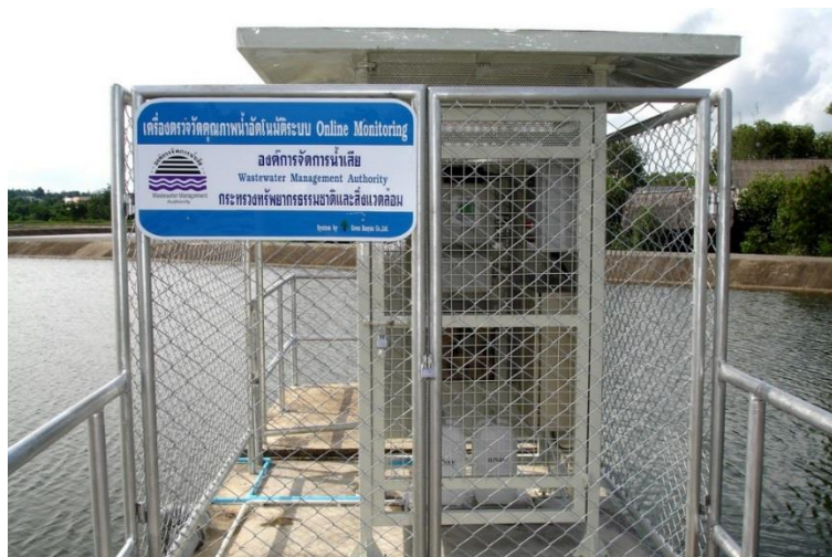
รูปที่ 6.12 เครื่องตรวจวัดคุณภาพน้ำอัตโนมัติระบบ Online Monitoring องค์การจัดการน้ำเสีย กระทรวงทรัพยากรธรรมชาติและสิ่งแวดล้อม
