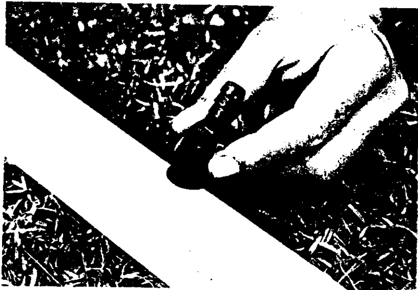
รูปที่ 8.6 การค้ำต่อประธานย่อยที่ไว้กับท่อแขนงหรือ
