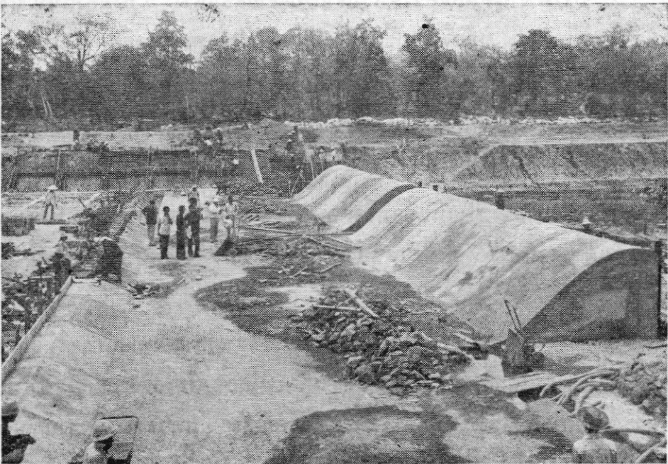
รูปที่ 11.1 งานก่อสร้างฝายคอนกรีต
