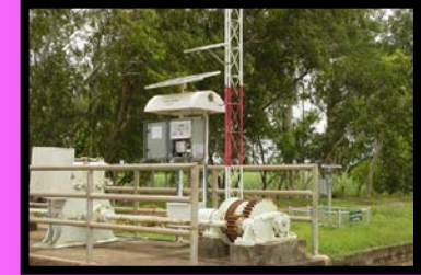
ติดตั้ง robogate km.20+300 5L-2L
