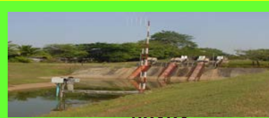
ระบบ SCADA โครงการส่งน้ำและบำรุงรักษาอุบล
