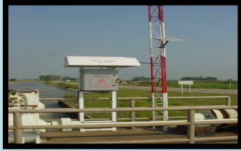
ติดตั้ง robogate km.3+650 5L-2L
