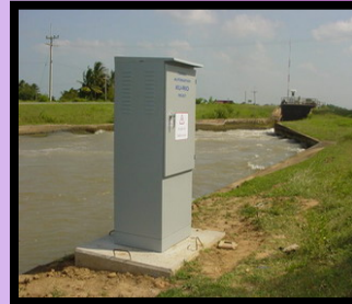
ติดตั้งตู้บ่อน้ำนิ่ง
