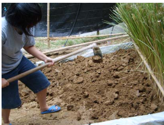
ภาพที่ 3.5 การพรวนดิน ก่อนทำการบดอัดดิน
