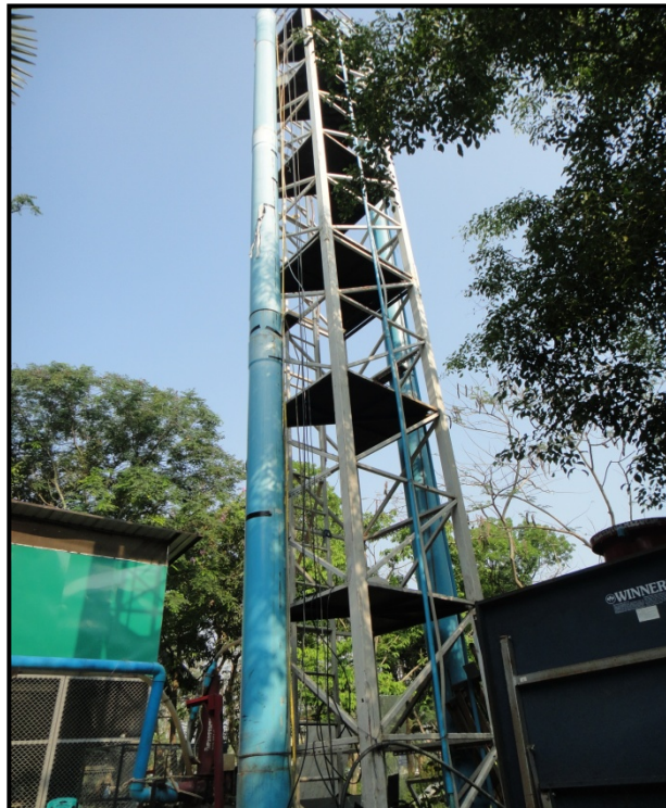
ภาพที่ 15 ถังน้ำสูง 12 เมตร
