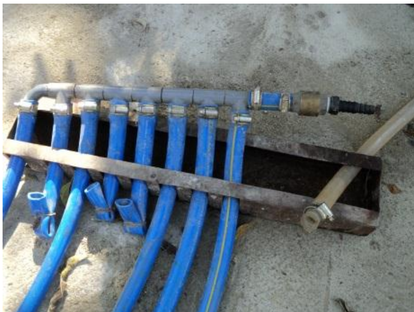
ภาพที่ 23 การต่อวาล์วกันกลับกับสายยางอ่อนด้านจ่ายน้ำ
