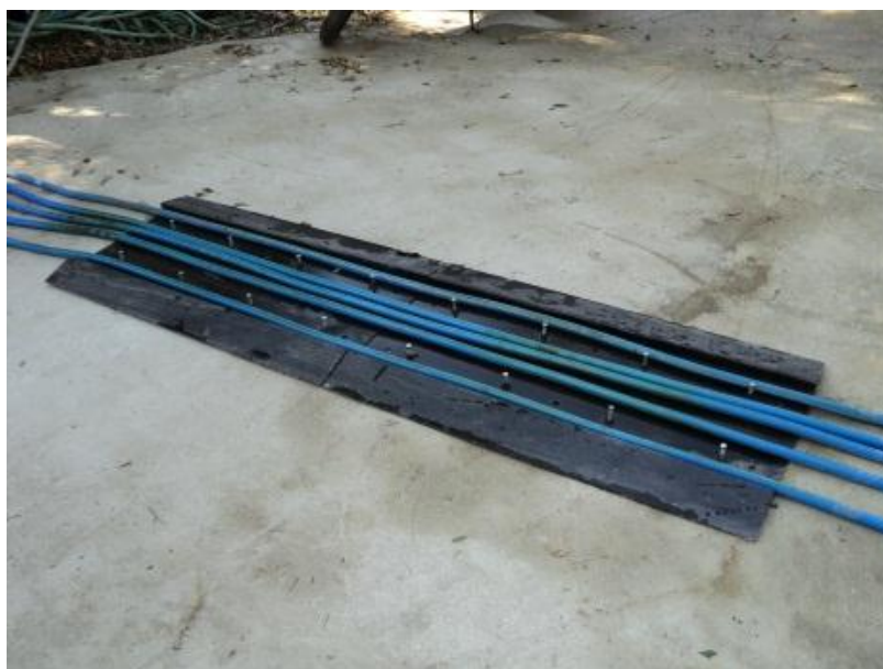
ภาพที่ 21 การวางสายยางอ่อนบนบล็อกเหล็ก
