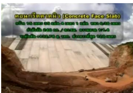
ภาพที่ 18 คอนกรีตคานผิวของเขื่อน
