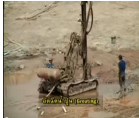
ภาพที่ 11 การอัดฉีดน้ำปูน
