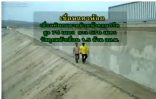
ภาพที่ 15 เขื่อนหินถมลาดผิวหน้าคอนกรีต
