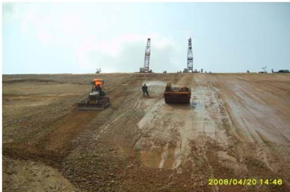
ภาพที่ 24 การบดอัดในระนาบเอียงทำให้ควบคุมคุณภาพที่ผิวได้ยาก ที่มา : ภูชงค์, 2553
