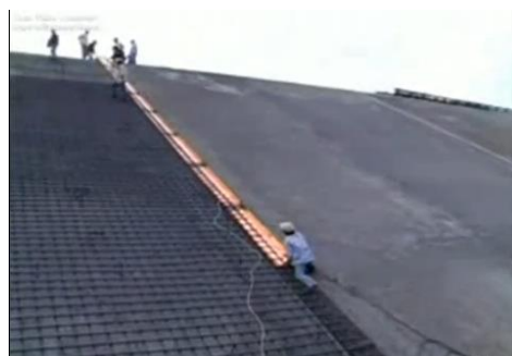
ภาพ 19 ติดตั้งเหล็กเสริมคอนกรีต
