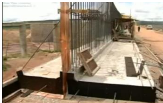
ภาพที่ 21 ฐานของเว็บวอลจะติดกับคอนกรีตคาดผิว
