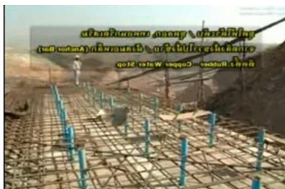
ภาพที่ 14 ฝังท่ออัดฉีดน้ำปูนเพื่อปรับปรุงฐานราก
