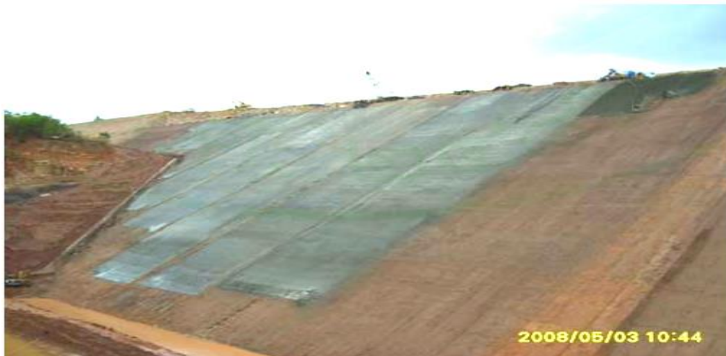
ภาพที่ 23 การพ่น Shotcrete ป้องกันการชะล้างหรือการกัดเซาะจากน้ำฝนในระหว่างการก่อสร้าง
