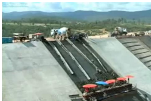
ภาพที่ 20 ติดตั้งรางพร้อมลิ้นรับคอนกรีตจากรถคอนกรีต
