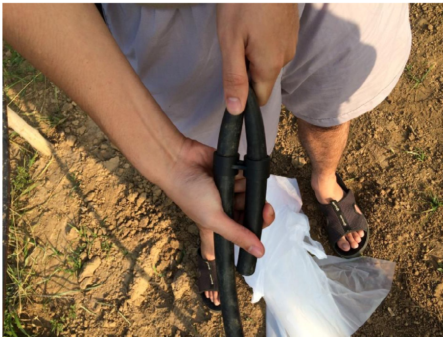
ภาพที่ 8 การใช้อุปกรณ์อุดปลายท่อ PE
