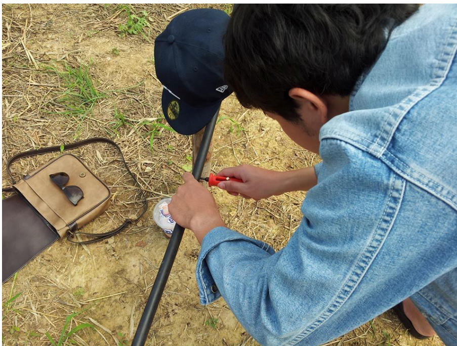
ภาพที่ 5 การติดตั้งหัวจ่ายน้ำกับท่อ PE
