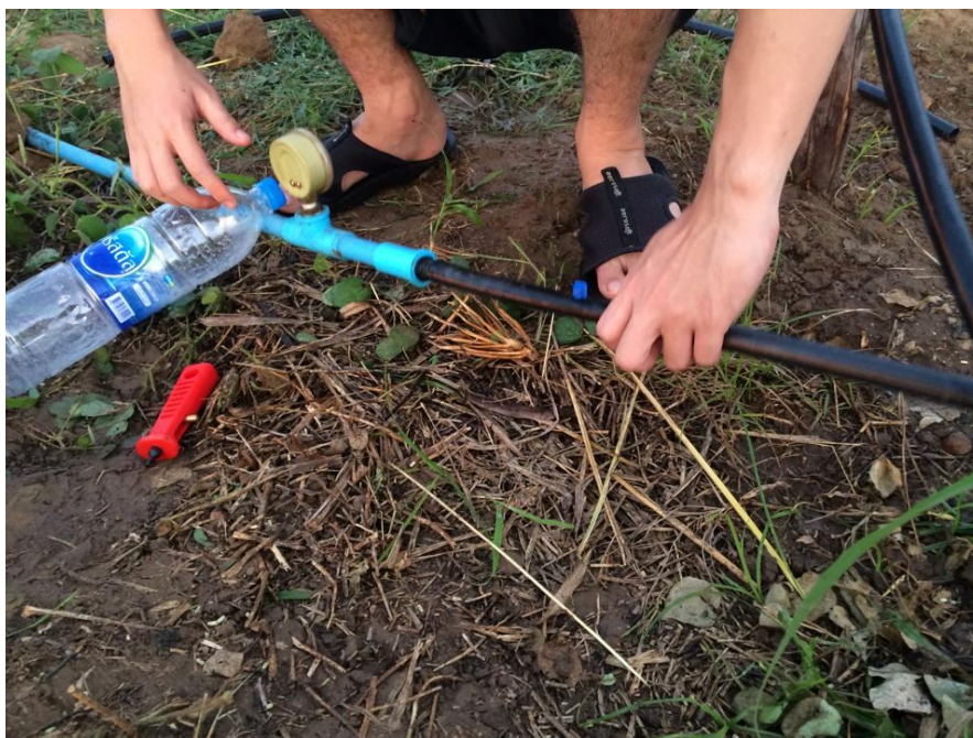
ภาพที่ 7 การติดตั้งหัวจ่ายน้ำสำหรับหาค่าอัตราการจ่ายน้ำที่ความดันใช้งาน 1.5 บาร์
