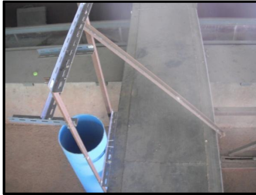
ภาพที่ 73 ท่อ PVC ติดตั้งกับโครงเหล็ก
