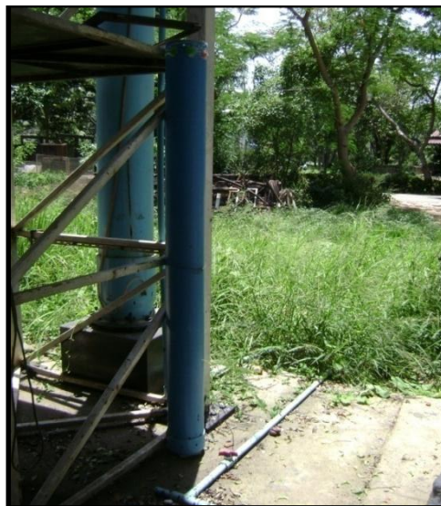
ภาพที่ 85 การติดตั้งท่อเพื่อทดลองการลดลงของน้ำ
