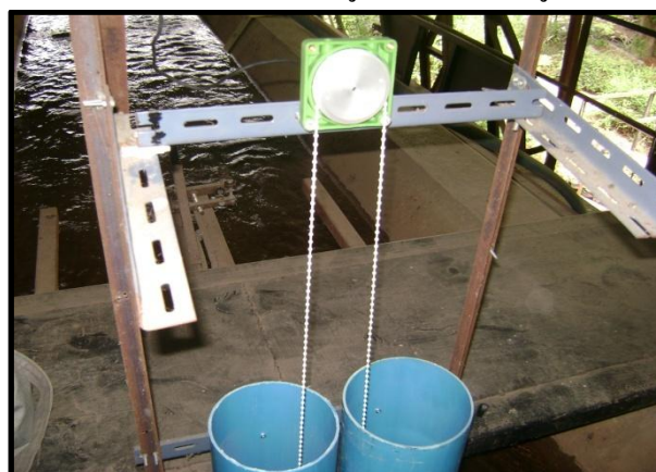
ภาพที่ 77 การติดตั้งท่อกู้ขนาด 6 นิ้ว
