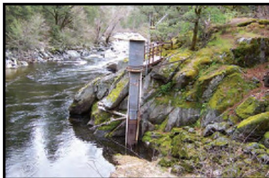
ภาพที่ 9 บ่อวัดระดับน้ำเชื่อมโยงแบบ USBR
