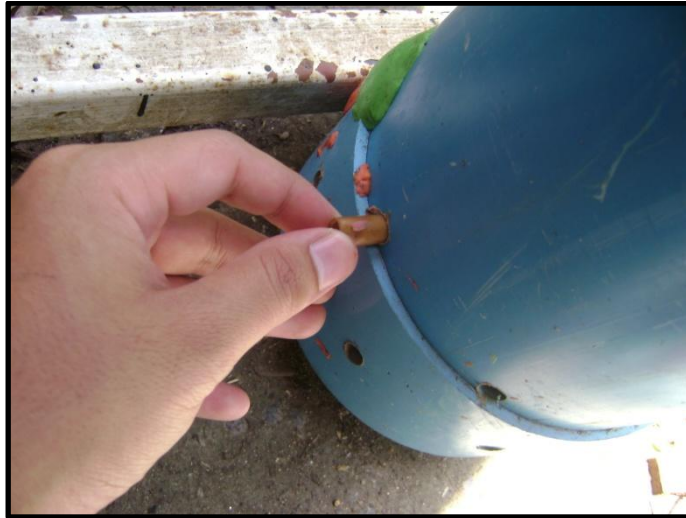
ภาพที่ 86 การอุดรูเจาะด้วยจุกยาง
