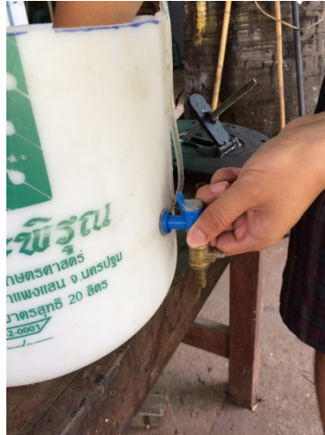
รูปที่ 3.12 การติดก๊อกสำหรับจ่ายน้ำออกจากถังรับน้ำด้านล่าง
