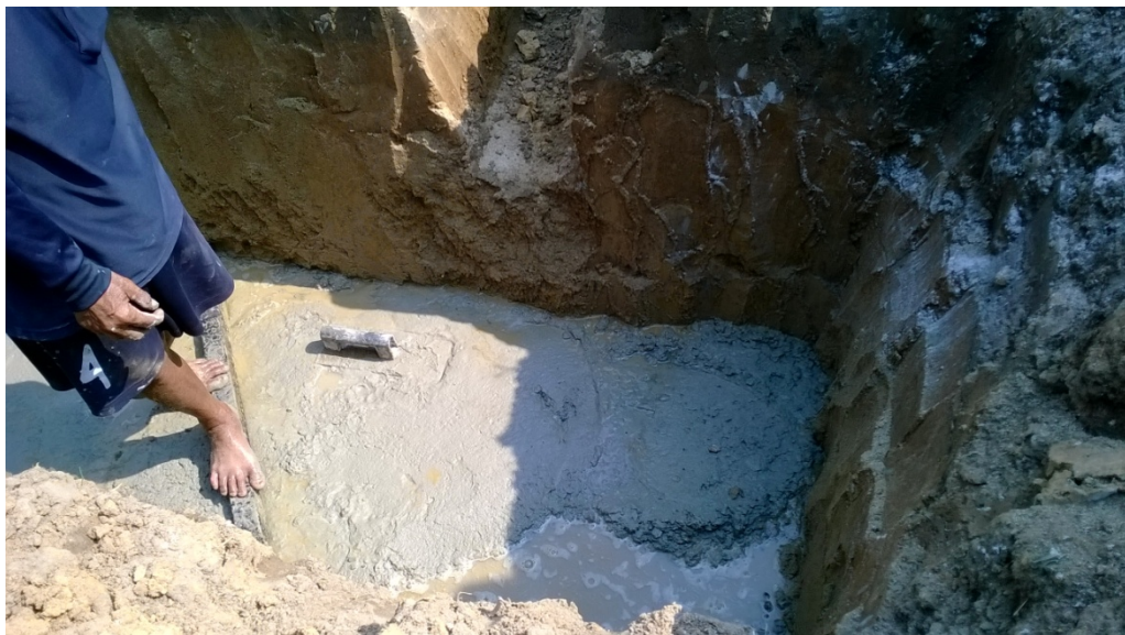
ภาพที่ 25 เทปูนที่กั้นบ่อน้ำระบาย
