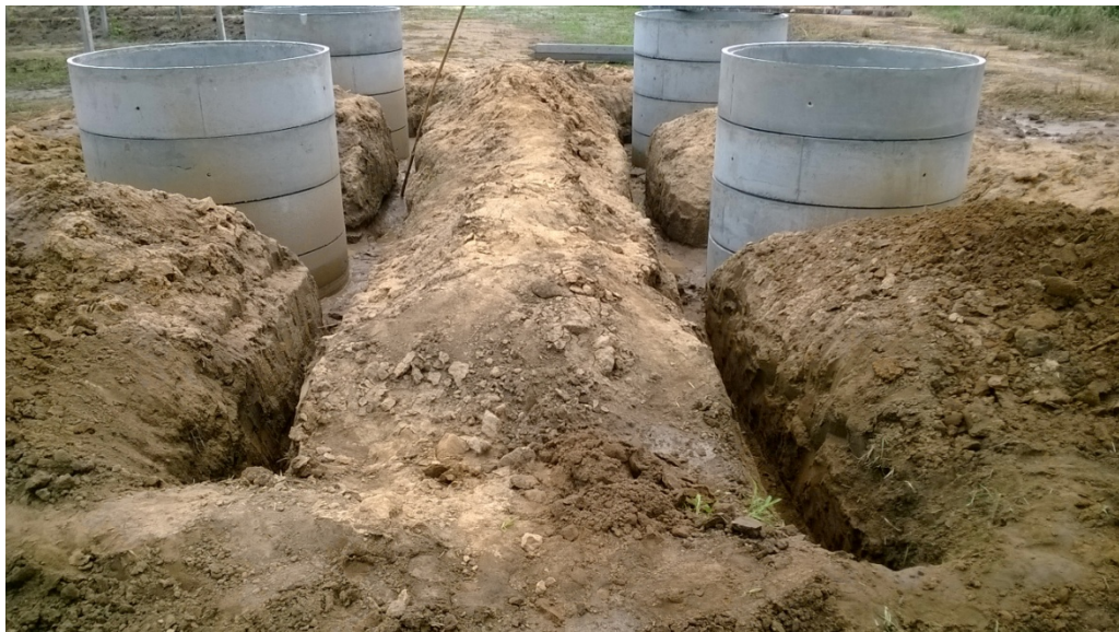
ภาพที่ 23 ขุดร่องเพื่อวางท่อระบายน้ำ
