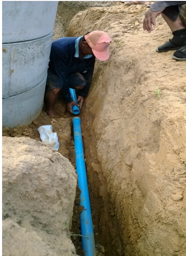
ภาพที่ 26 วางท่อระบายน้ำจากถังวัดการใช้น้ำของพีช
