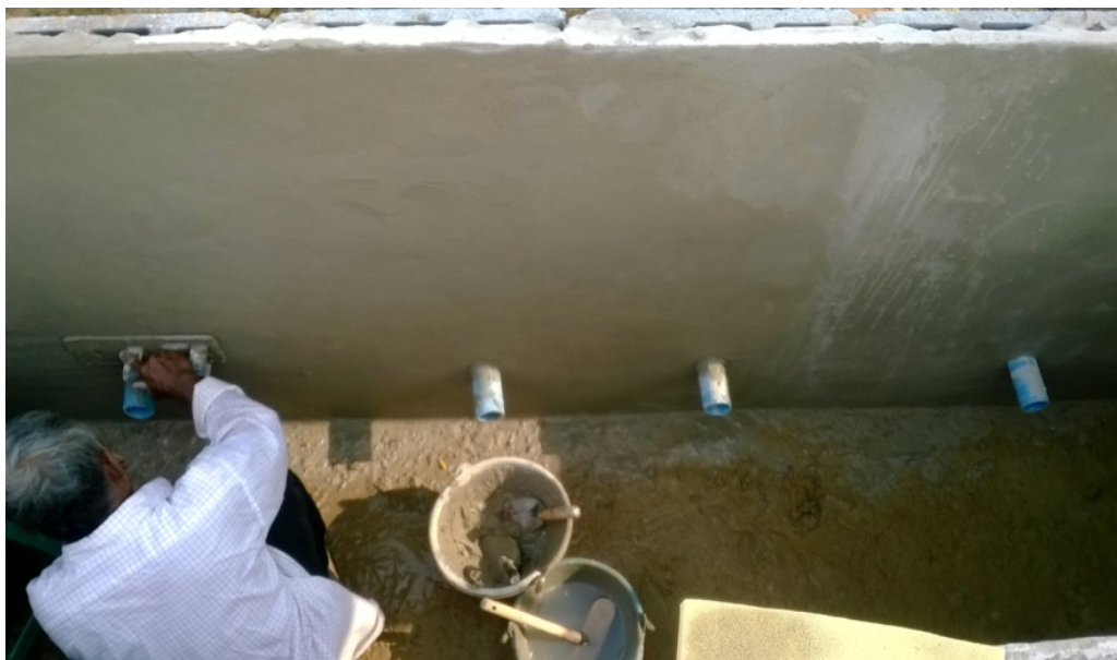
ภาพที่ 29 ฉาบปูนในบ่อวัดน้ำระบายติดตั้ง โดยต่อในแต่ละถังจะมีท่อระบายน้ำพร้อมวาล์วปิดน้ำที่ระบายออกจากตัวถังวัดการใช้น้ำของพีช
