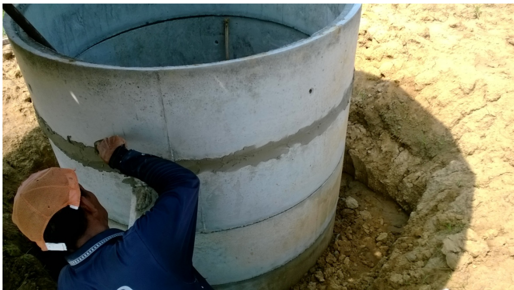
ภาพที่ 27 ฉาบปูนปิดรอยต่อของถังวัดการใช้น้ำของพีช
