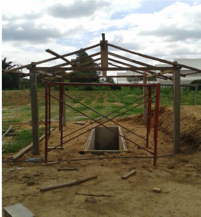
ภาพที่ 36 สร้างหลังคาถักนุ่นคลุมบ่อวัดน้ำระบาย
