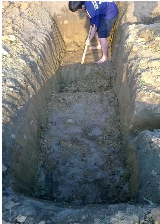
ภาพที่ 24 ขุดบ่อเพื่อสร้างบ่อน้ำระบาย
