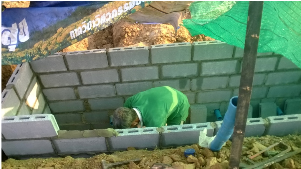
ภาพที่ 28 ก่ออิฐในบ่อวัดการใช้น้ำของพีช
