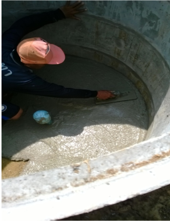
ภาพที่ 30 เทปูนที่กั้นถ่วงวัดการใช้น้ำของพืชและเคลือบบ่อด้วยน้ำยากันซึม
