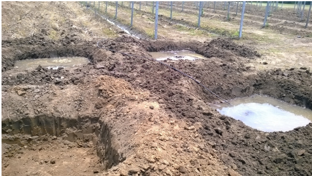
ภาพที่ 21 ขุดหลุมเพื่อวางถังวัดการใช้น้ำของพืช
