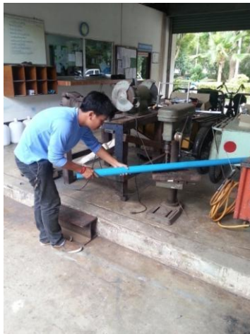
ภาพที่ 13 การเจาะรูระบายน้ำ
