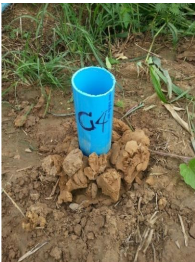
ภาพที่ 15 ตัวอย่างท่อตรวจวัดที่ทำการติดตั้งเรียบร้อยแล้ว
