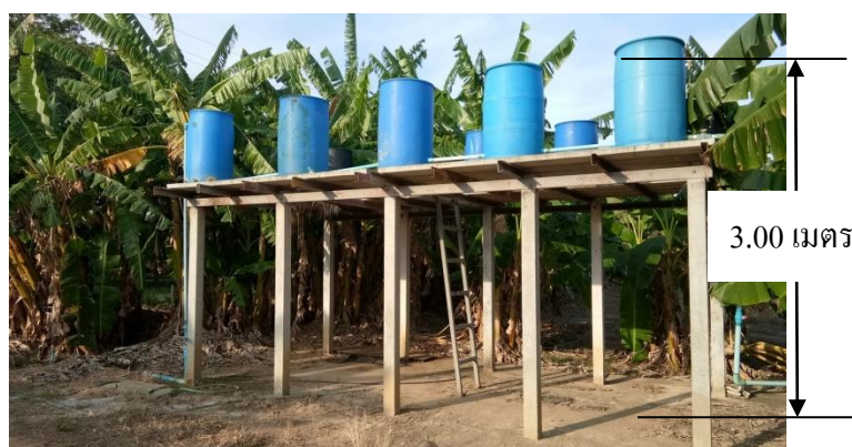
ภาพที่ 3- 1 ถังจ่ายน้ำสูง 3 เมตร
