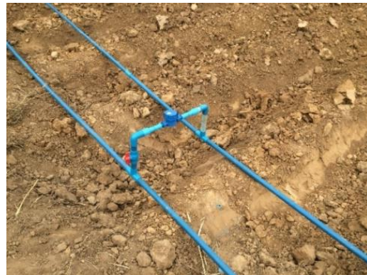
ภาพที่ 3- 5 วาล์วเปิด/ปิด น้ำและเมตรวัดน้ำ
