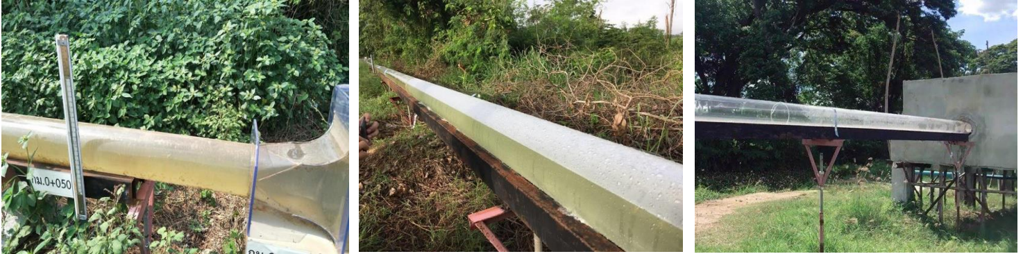
รูปที่ 4(c) น้ำจะไหลเข้าสู่ท่ออะคริลิกไปยังทางออกอุโมงค์ผิวน้ำที่มีอาคารรับน้ำอยู่
