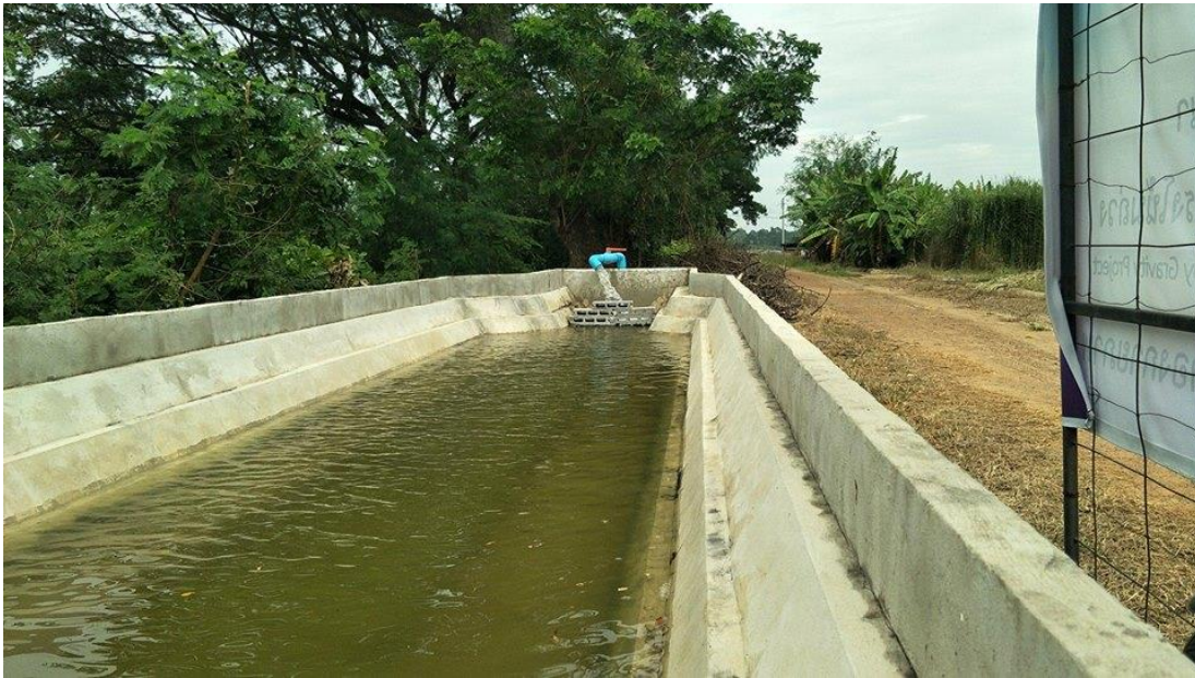
รูปที่ 4(a) สุ่มน้ำเข้าบ่อเพื่อให้เกิดการตกตะกอนก่อนที่น้ำจะไหลเข้าสู่อาคารรับน้ำ
