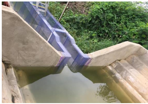
รูปที่ 4(b) น้ำจะไหลเข้าสู่อาคารรับน้ำทางเข้าอุโมงค์ที่มีประตูควบคุมการปิด-เปิด ซึ่งจะมีगेจวัดระดับน้ำติดตั้งอยู่ที่ บริเวณด้านเหนือน้ำและด้านท้ายน้ำ
