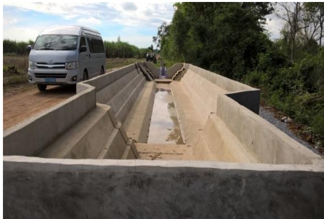
รูปที่ 3(a) บริเวณทางด้านหัวงานของท่ออุโมงค์จะเชื่อมกับบ่อดักตะกอนที่มีความยาว 8.60 เมตร
