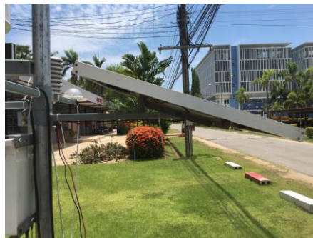
รูปที่ 3-37 การติดตั้งแผงโซลาร์เซลล์
