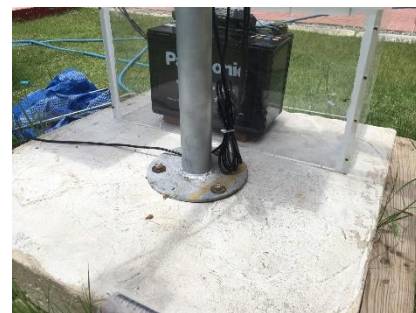
รูปที่ 3-34 การยึดติดเสาสถานีกับฐานเสา
