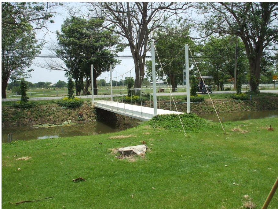
รูปที่25 สะพานหลังสโมสรคณะวิศวกรรมศาสตร์ กำแพงแสน
