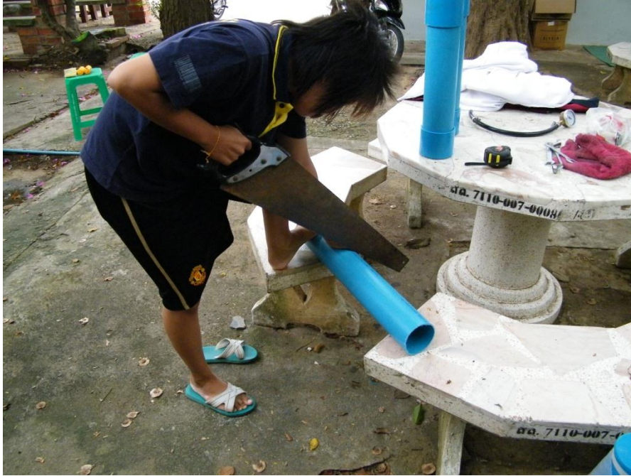
ภาพผนวกที่ ง.1.1 ตัดท่อ PVC ขนาดต่างๆ
