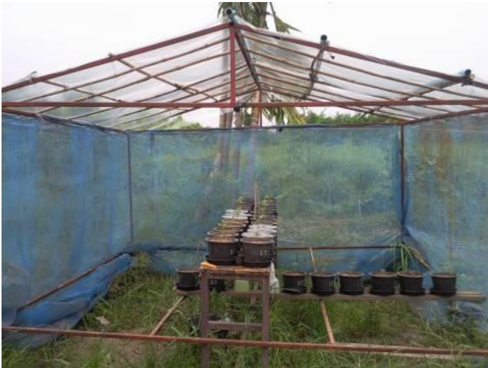
ภาพที่ 3.2 โรงเรือนกลางแจ้งที่มุงหลังคาด้วยพลาสติกกันยูวีและล้อมด้วยตาข่าย
