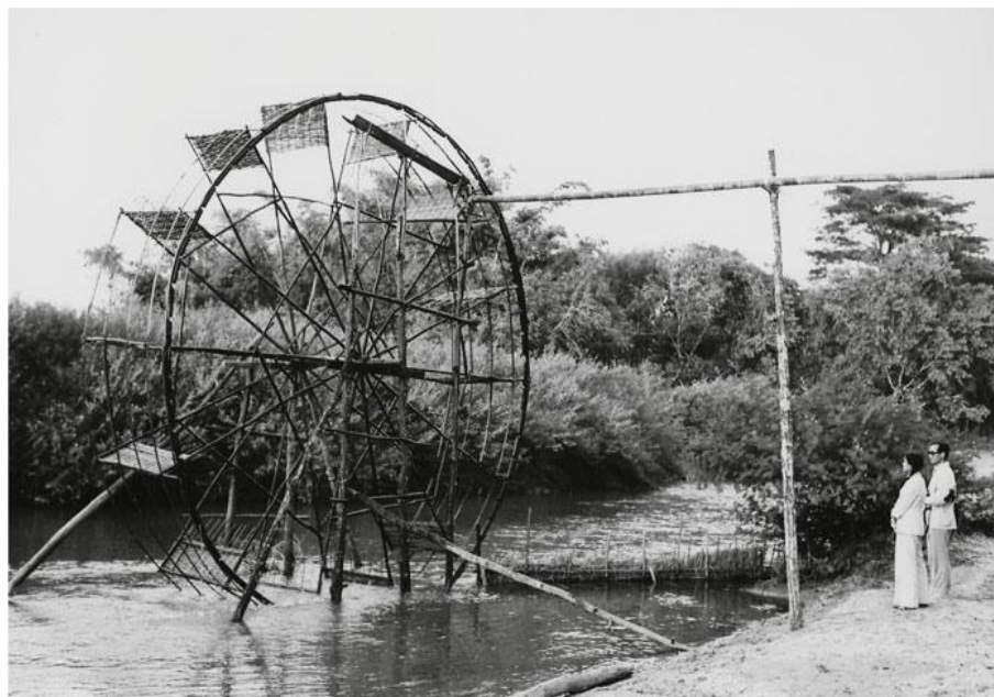
ภาพที่ 2.9 กังหันกระบอกหรือหลุก (ที่มา : บรรจง,2525)
