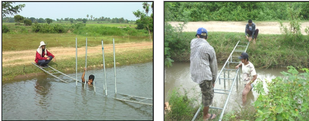
ภาพที่ 23 การติดตั้งสะพานเหล็กชั่วคราว
