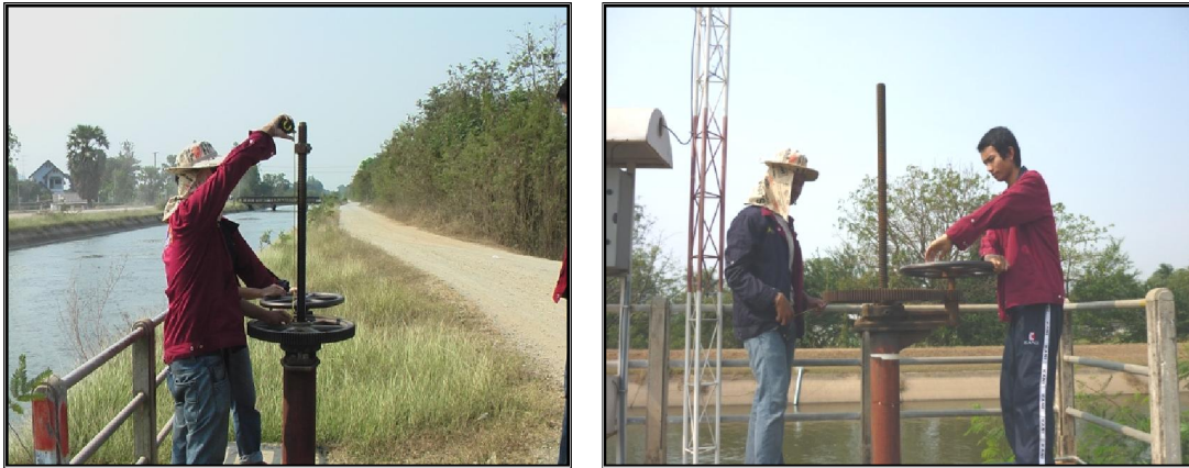
ภาพที่ 22 การปรับระยะเปิดบานของท่อระบายน้ำปากคลอง 4L-5L-2L และ 2R-5L-2L
