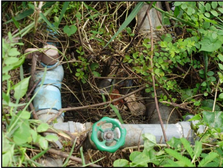
❖ รูปที่ 3.5 วาล์วของแนวท่อที่ทำการแยกไปตามบ้าน
