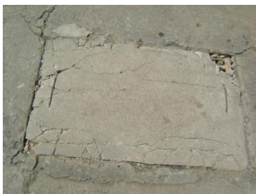
ท่อรับน้ำเสีย หัวมูมถนนกลางตลาดบางหลวงฝั่งซ้าย
