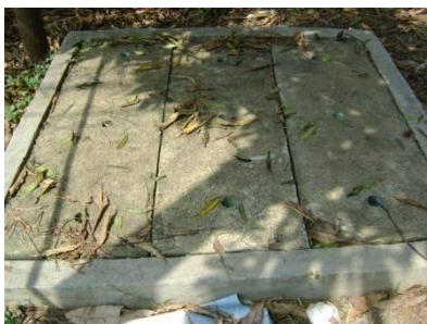
ท่อรับน้ำเสียดังข้างวัดบางหลวง ซอยเทศบาล 10
