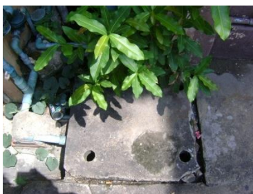
ท่อรับน้ำเสีย อยู่ตรงกลางซอยกลางตลาดฝั่งขวา
