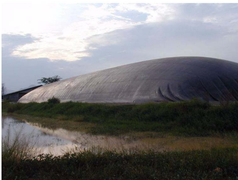
รูปที่ 19 บ่อหมักไม่ใช้อากาศแบบปิดฝา (บริษัท แชน.อี.68 คอนซัลติ้ง เอ็นจิเนียรส์ จำกัด, 2554)
