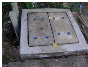
ท่อรับน้ำเสีย หน้าร้านก๋วยเตี๋ยว ซอยเทศบาล 6
