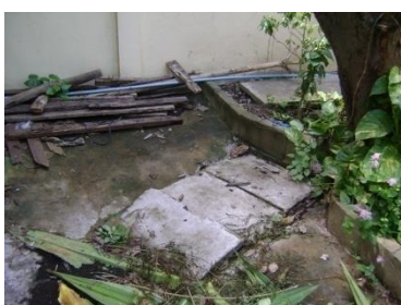
ท่อรับน้ำเสีย อยู่ในบริเวณ โรงเจ
