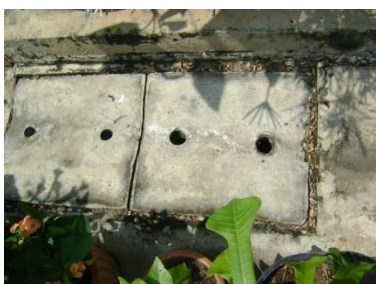
ท่อรับน้ำเสี้ยว อยู่หน้าร้านขายของหน้าโรงเรียน
