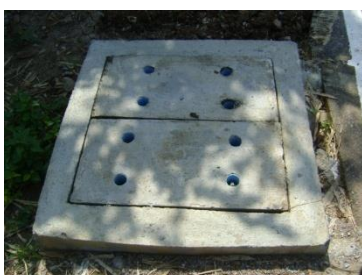
ท่อรับน้ำเสีย ข้างร้านก๋วยเตี๋ยว ซอยเทศบาล 6
