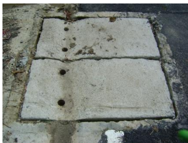
ท่อรับน้ำเสียดังอยู่ระหว่างซอย 8 กับซอย 10 หัวมุดถนนฝั่งซ้าย
