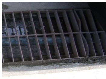
ท่อรับน้ำเสีย อยู่ตรงป้ายของทางตรงสามแยก
