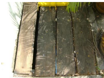
ท่อรับน้ำเสีย หัวมุมโรงเรียนวัดบางหลวง
