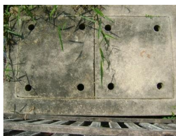
ท่อรับน้ำเสีย หลังสำนักงานบรรเทาสาธารณภัย
