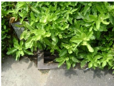
ท่อรับน้ำเสีย หน้าร้านก๋วยเตี๋ยวบริเวณ โรงหนังเก่า
