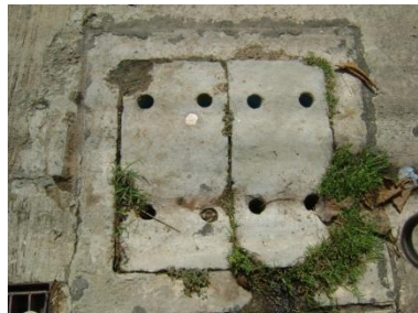
ท่อรับน้ำเสี้ยว หัวมุมท่ารถเมย์ ซอยเทศบาล 4
