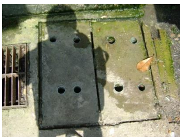
ท่อน้ำเสีย อยู่หลังสถานีตำรวจท่องเที่ยว
