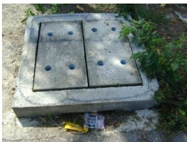
ท่อรับน้ำเสี้ยว หัวมุมฝั่งซ้ายมือของหัวมุมถนน
