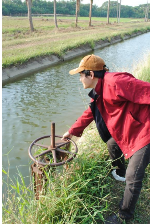
รูปที่ 3.11 การปรับบานประตูส่งน้ำปากคลอง
