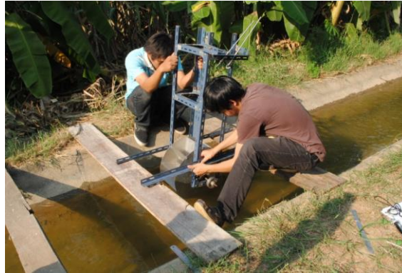
รูปที่ 3.6 แสดงการติดตั้งกักน้ำ
