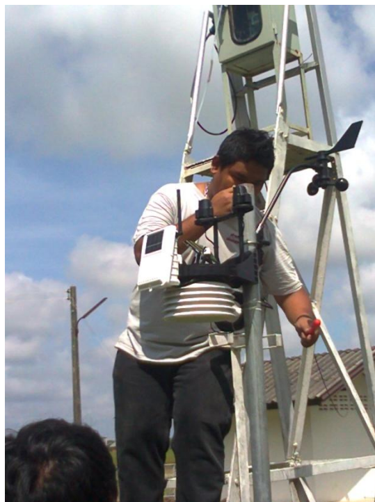
ภาพที่ 33 การติดตั้งเครื่องตรวจวัดอากาศไปติดตั้งในสถานีอุตุนิยมวิทยา
