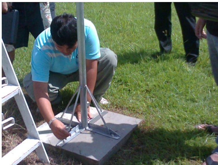
ภาพที่ 32 การติดตั้งเครื่องตรวจวัดอากาศไปติดตั้งในสถานีอุตุนิยมวิทยา
