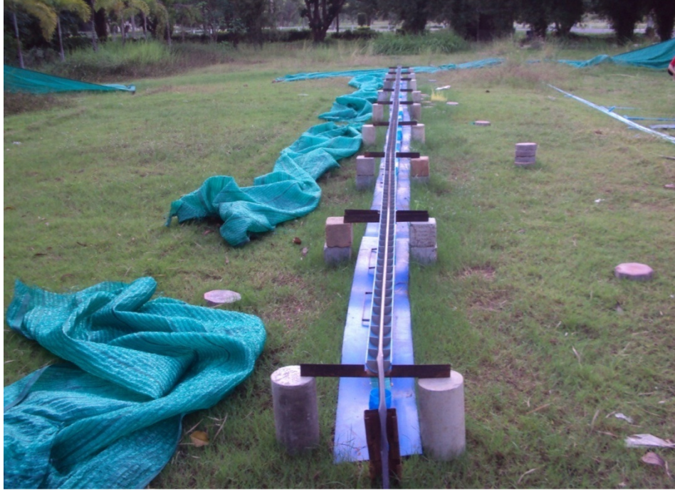
ภาพที่ 3.7 การติดตั้งรางสำหรับการทดสอบ โดยติดตั้งให้มีระดับที่เท่ากันหมดตลอดทุกช่วงเป็นระยะทาง 15 เมตร
