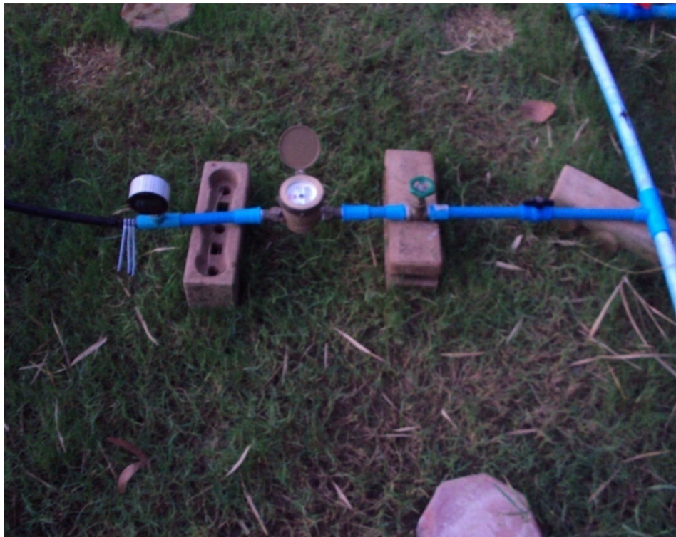
ภาพที่ 3.8 การติดตั้งท่อสำหรับส่งน้ำให้กับสายน้ำหยด พร้อมทั้งเครื่องมือวัดความดัน และเครื่องมือวัดอัตราการไหลของน้ำที่ส่งให้กับสายน้ำหยด
