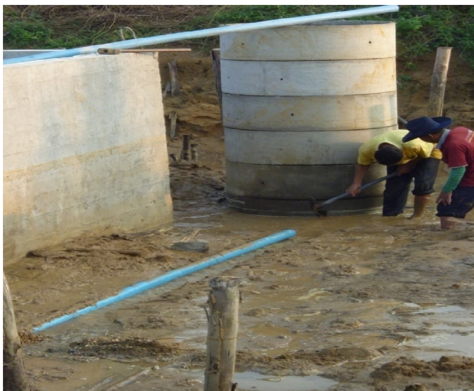
ภาพที่ 22 ทำการเจาะรูบ่อพักน้ำเพื่อให้ท่อไนโตรเจนและท่อ PVC สอดเข้าได้
