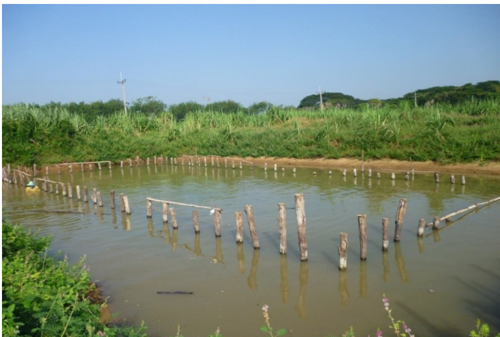
ภาพที่ 18 การปักไม้เป็นแนวกันดินสไลด์ตัว
