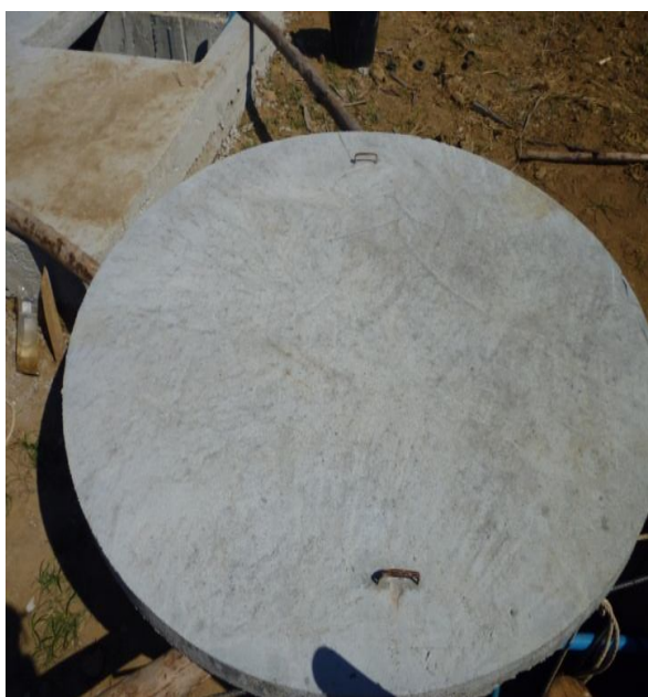
ภาพที่ 13 ฝาปิดร่องคอนกรีตขนาด 1.5 m.
