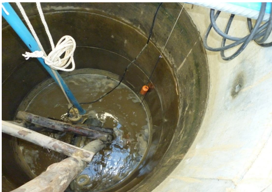
ภาพที่ 24 การติดตั้งเครื่องสูบน้ำในบ่อพักน้ำ
