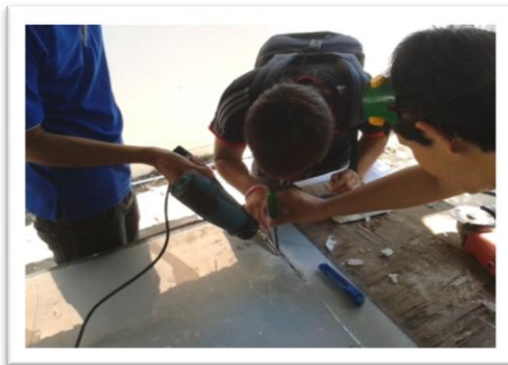
รูปที่ 3.12 แสดงการใช้ลมร้อนเป่าพลาสติก EVA
