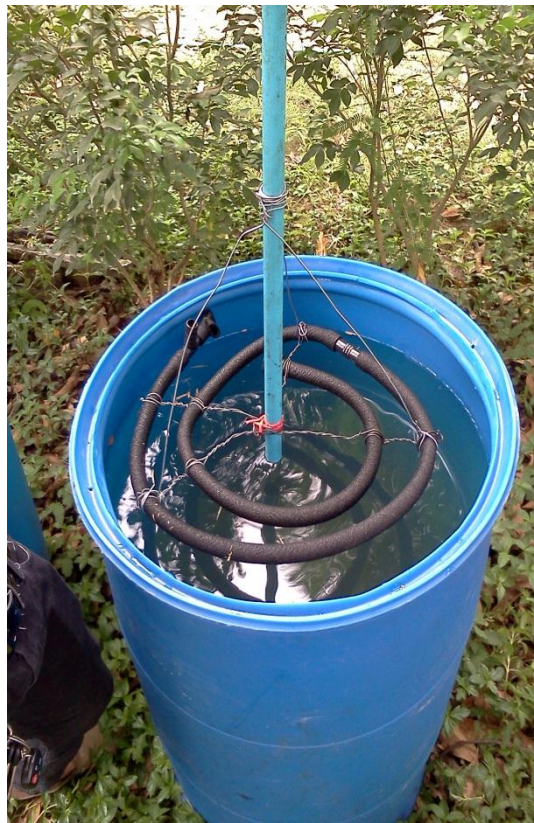
รูปที่ 3.13 รูปการติดตั้งชุดสายยางเติมอากาศแบบขดวงกลม
