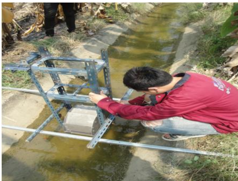
รูปที่ 3.6 การติดตั้งชุดอุปกรณ์กักัน
