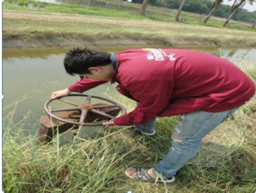
รูปที่ 3.12 การปรับระดับบานประตู เพื่อเปลี่ยนความเร็วของกระแสน้ำ
