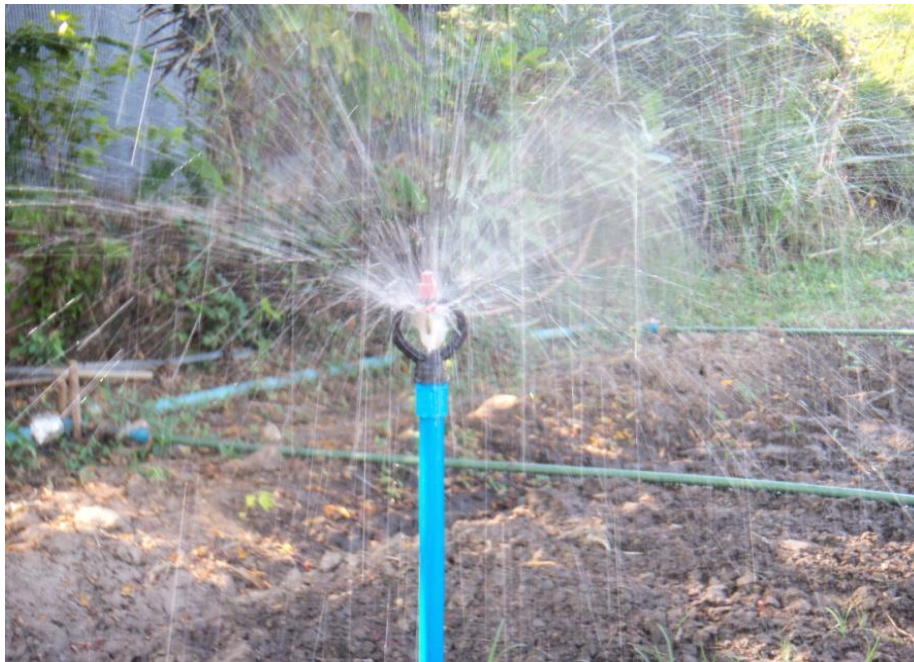
ภาพผนวก ก-9 การทดสอบประสิทธิภาพของระบบสปริงเกอร์ (หัวจ่ายน้ำเดิมของเกษตรกร) แปลงผักกาด นางฉวี สวนแก้ว
