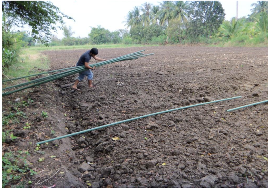
รูปที่ 22 การเตรียมแปลงและ วางระบบจ่ายน้ำแบบสปริงเกลอร์
