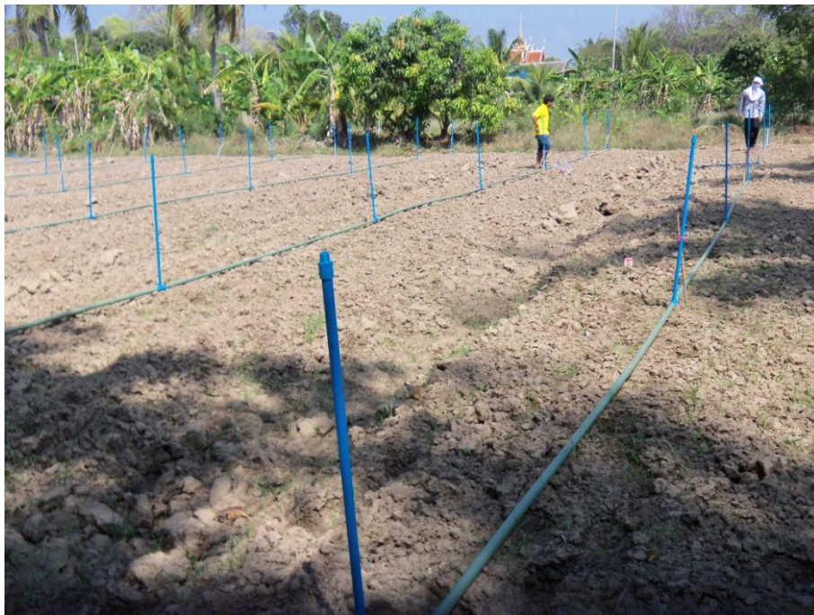
รูปที่ 23 การติดตั้งท่อแขนง, ท่อ riser และ ติดตั้งหัวจ่ายน้ำ “ชลประทาน 1”
