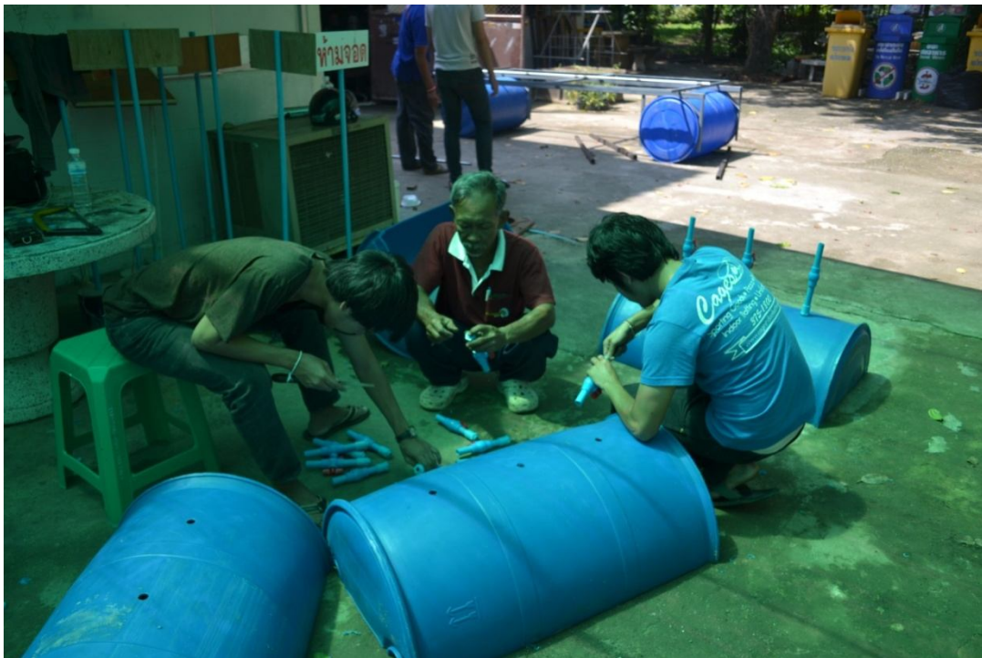
ภาพผนวกที่ ข16 การติดตั้งท่อระบายน้ำที่รางเพาะปลูก
