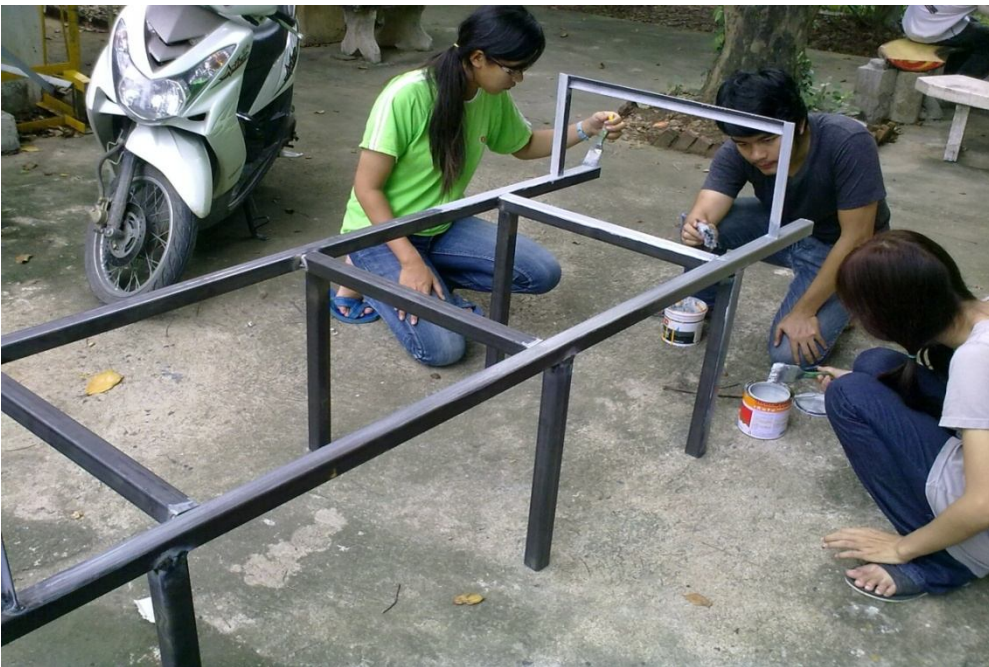
ภาพผนวกที่ ข21 การทาสีแทนรับรางเพาะปลูก
