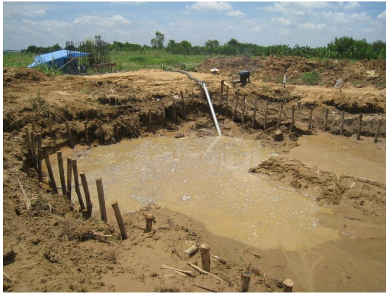
ภาพที่ 19 สูบน้ำออก
