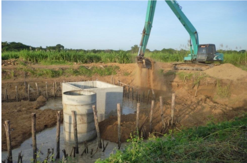
ภาพที่ 21 นำถัง Lysimeter และห้องเก็บผลลง แล้วกลบดิน
