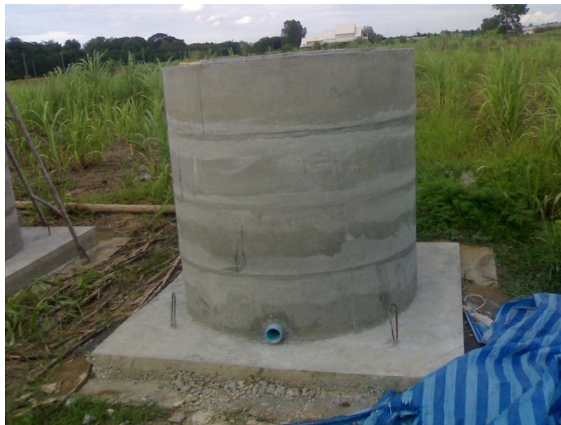
ภาพที่ 18 สร้างถัง Lysimeter
