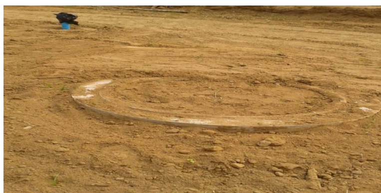
ภาพที่ 23 ปรับพื้นที่บริเวณแปลงทดลองให้มีระดับต่ำกว่า Lysimeter ประมาณ 5 – 10 เซนติเมตร
