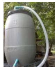
2. ท่อส่งน้ำเข้าถัง
