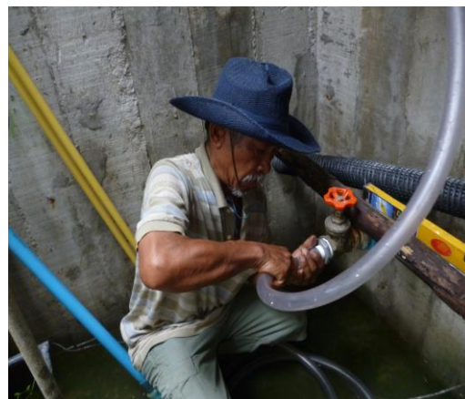
ภาพที่ 28 ต่อสายยาง 1 นิ้วเข้ากับท่อ 2 นิ้ว
