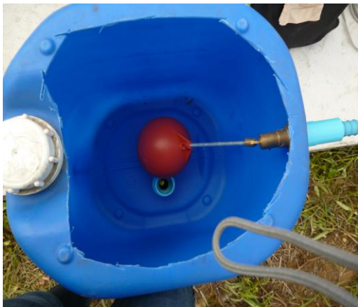
ภาพที่ 23 ติดตั้งลูกลอย
