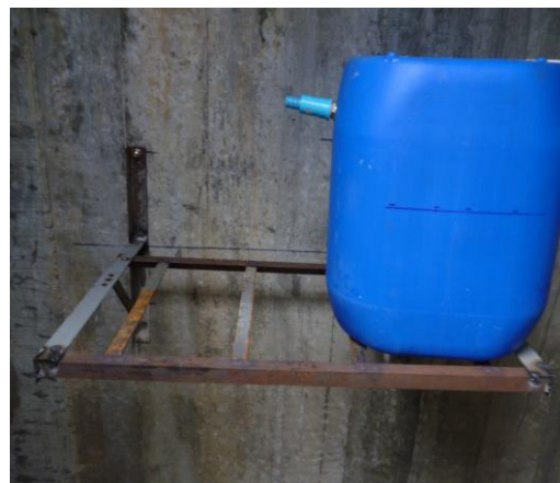
ภาพที่ 26 ติดตั้งถังควบคุมระดับน้ำใต้ดิน
