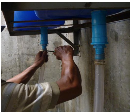
ภาพที่ 27 ต่อสายยาง 1 นิ้วจากถังควบคุมระดับ
