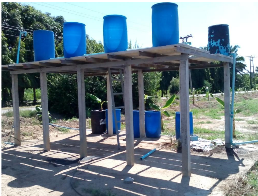
ภาพที่ 3.15 ถังจ่ายน้ำสูงประมาณ 3 m.
