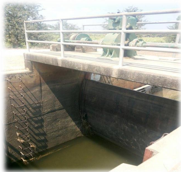
ภาพผนวกที่ 12 ท่อระบายน้ำกลางคลอง คลอง 5L-2L กม. 26+401
