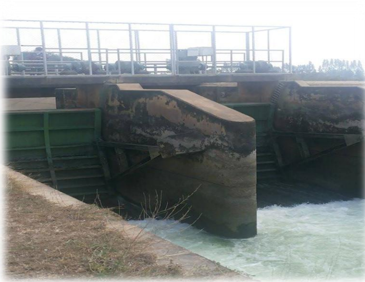
ภาพผนวกที่ 7 สะพานรถยนต์ คลอง 5L-2L กม. 1+236
