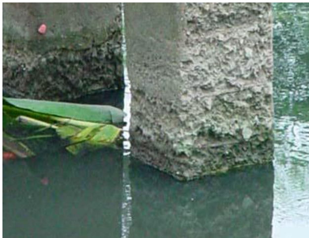
ภาพที่ 2-1 การสลายตัวของคอนกรีต
