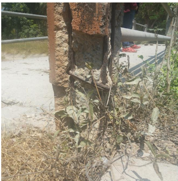
ภาพที่ 4-3 การเกิดรอยร้าวทะลุโครงสร้างของสะพานคนเดิน คลอง 4R-5L-2L กม. 1+375
