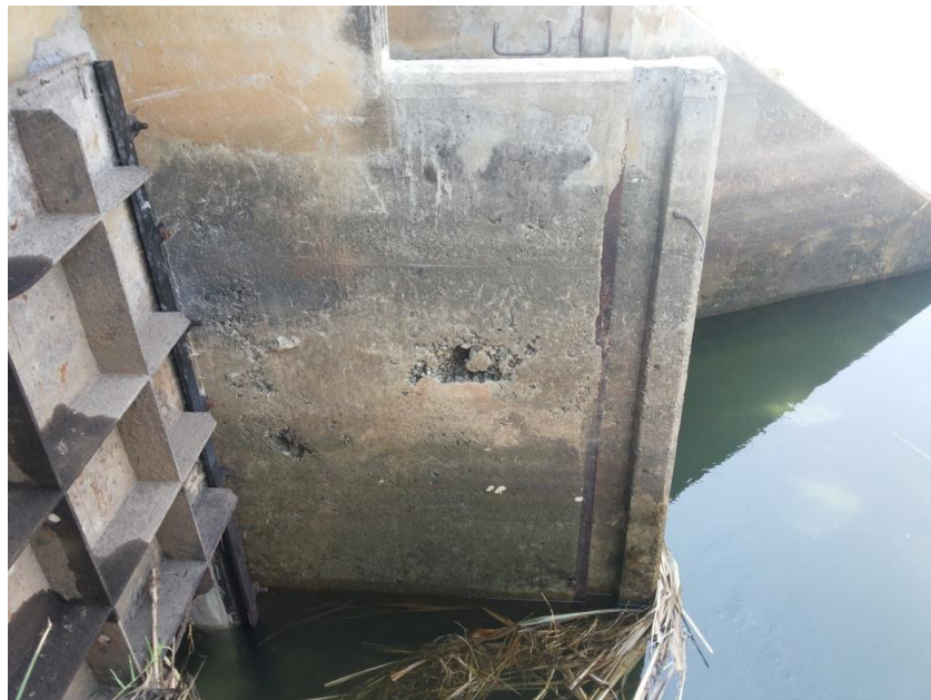
ภาพที่ 4-6 ผิวของโครงสร้างเสียหายเนื่องจากการตอแบบของสะพานรถยนต์คลอง 2L กม. 21+216
