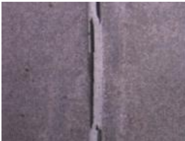
ภาพที่ 2-3 การวิบัติของวัสดุอุดรอยต่อ
