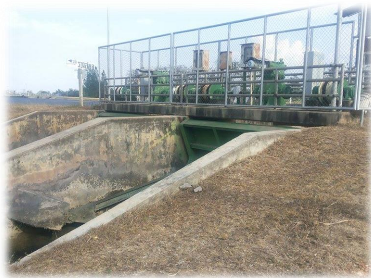
ภาพผนวกที่ 6 ประตูระบายน้ำปากคลอง คลอง 5L-2L กม. 0+000
