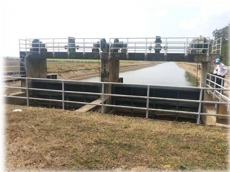
ภาพผนวกที่ 4 ท่อลอดทางหลวง คลอง 2L กม. 27+885.271
