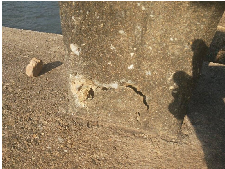
ภาพที่ 4-6 ผิวของโครงสร้างเสียหายเนื่องจากการตอแบบของสะพานรถยนต์คลอง 2L กม. 21+216
