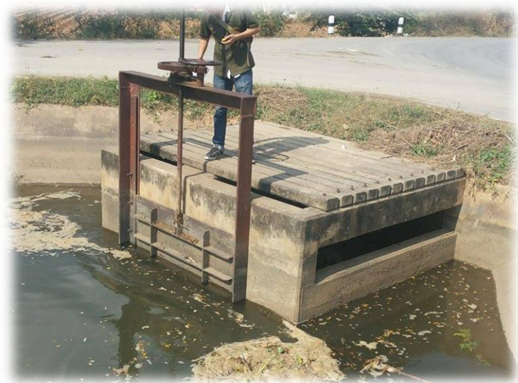
ภาพผนวกที่ 18 ท่อลอดถนน (อาคารอัดน้ำ) คลอง 1R-5L-2L กม. 4+709
