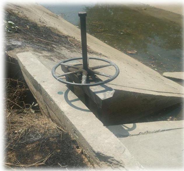
ภาพผนวกที่ 13 ท่อลอดถนน (อาคารอัดน้ำ) คลอง 5L-2L กม. 27+950
