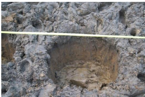
ภาพที่ 13 ขณะขุดดินเพื่อวางถัง
