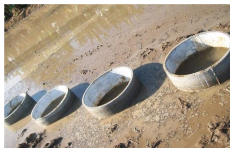
ภาพที่ 16 ถังที่ทำการติดตั้งแล้วเสร็จทั้ง 4 ถัง (ถังที่ 1 นับจากทางขวามือ ถัดมาคือ ถังที่ 2, 3 และ 4 ตามลำดับ)
