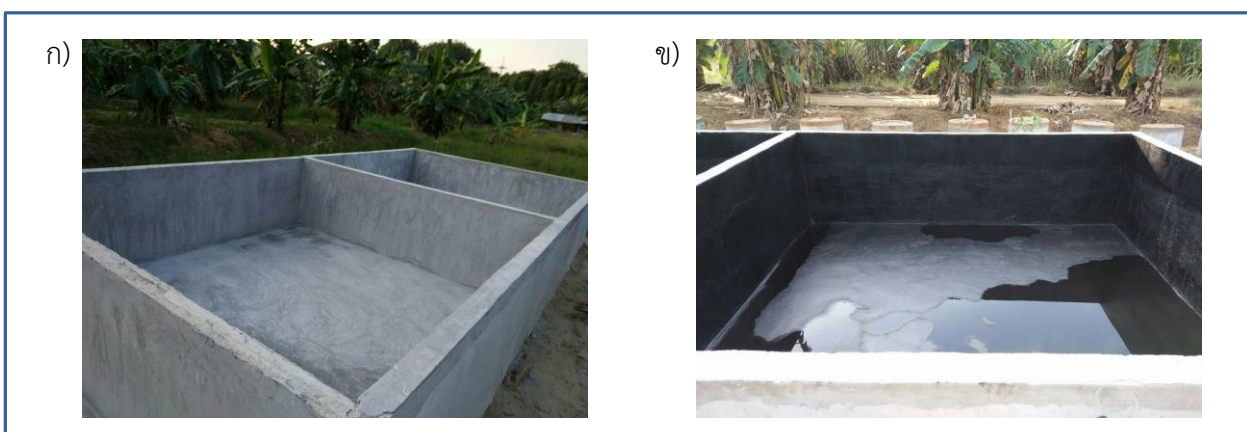
รูปที่ 2 การปรับปรุงบ่อซีเมนต์ ก) บ่อซีเมนต์ที่ยังไม่ได้ปรับปรุง ข) บ่อซีเมนต์ที่ปรับปรุงแล้ว
