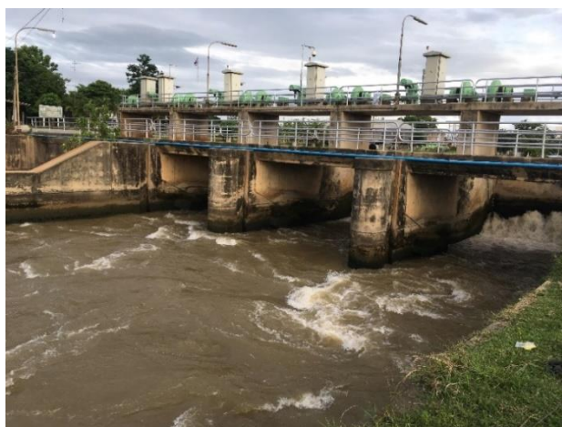
ภาพที่ 12 ประตูระบายน้ำคลองส่งน้ำ 2ซ้าย และคลองส่งน้ำสายใหญ่ฝั่งซ้าย
