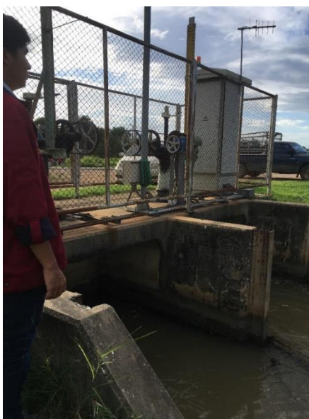
ภาพที่ 13 ประตุน้ำระบายน้ำคลองส่งน้ำ 1ซ้าย
