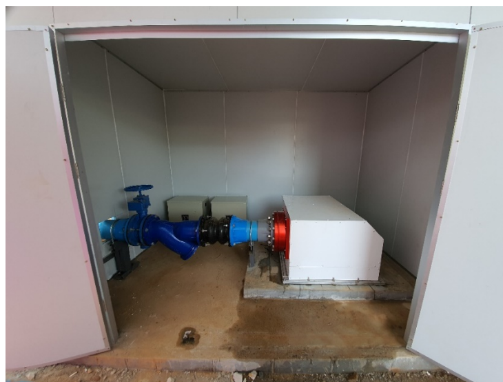
รูปที่ 4-11 แสดงการติดตั้งเครื่องกำเนิดไฟฟ้า
