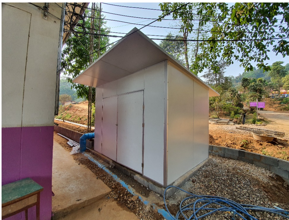
รูปที่ 4-10 แสดงภาพหลังก่อสร้างห้องกำเนิดไฟฟ้า
