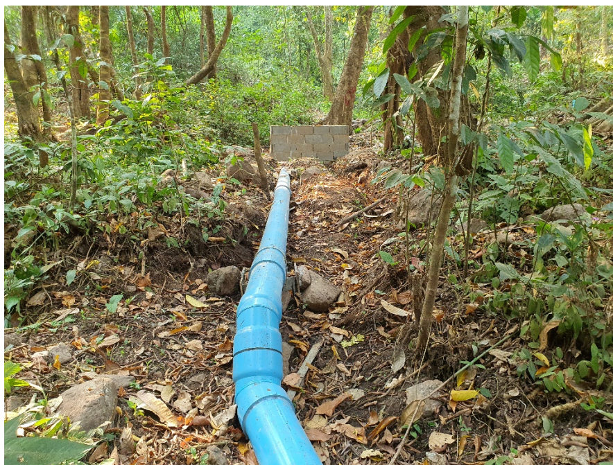
รูปผนวกที่ 8 แสดงการติดตั้งท่อลำเลียงน้ำไปยังเครื่องกำเนิดไฟฟ้า
