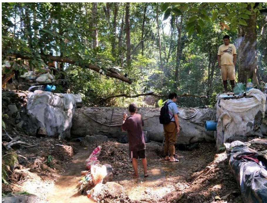
รูปที่ 4-8 แสดงการก่อสร้างฝายหินทิ้ง
