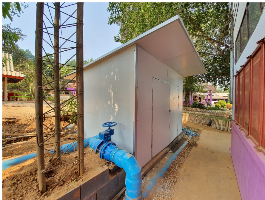
รูปผนวกที่ 17 แสดงภาพหลังก่อสร้างห้องกำเนิดไฟฟ้า
