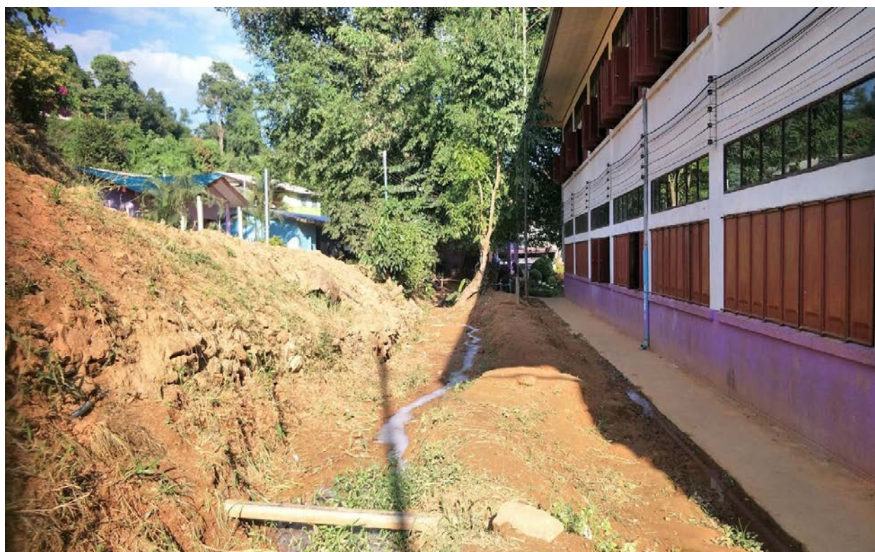
รูปผนวกที่ 3 แสดงสภาพทางกายภาพจุดติดตั้งเครื่องกำเนิดไฟฟ้า
