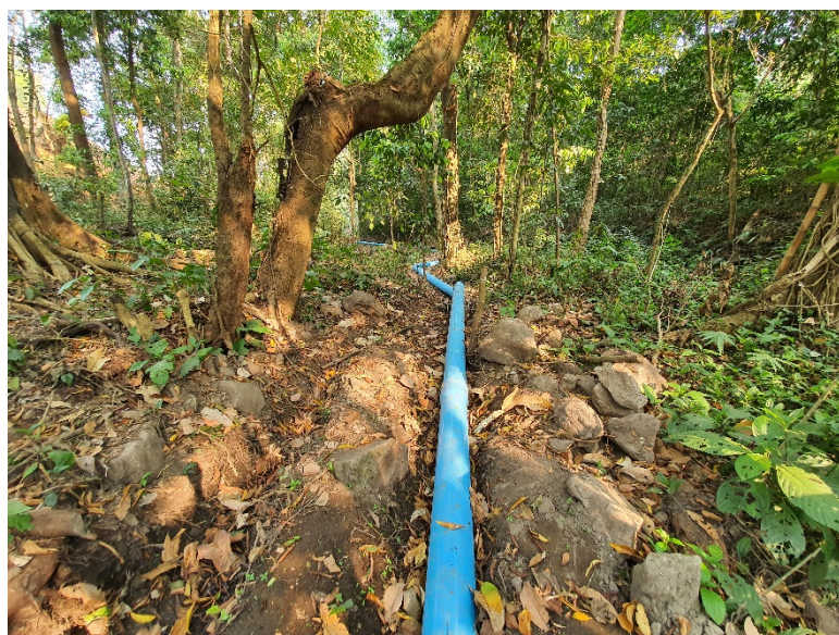
รูปผนวกที่ 7 แสดงการติดตั้งท่อลำเลียงน้ำไปยังเครื่องกำเนิดไฟฟ้า
