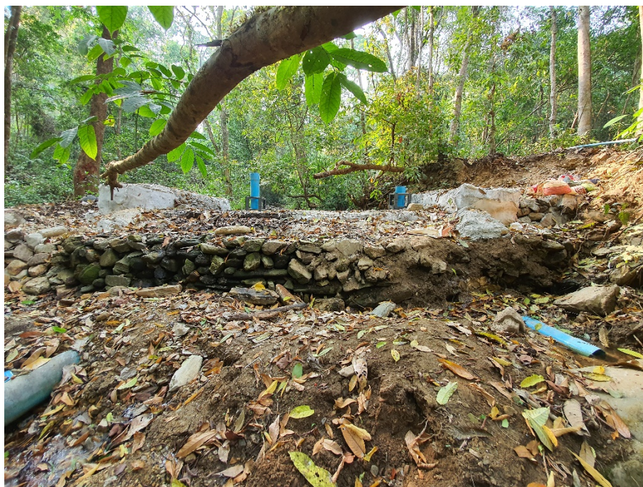
รูปผนวกที่ 6 แสดงผลการติดตั้งบ่อกรองสูบน้ำ
