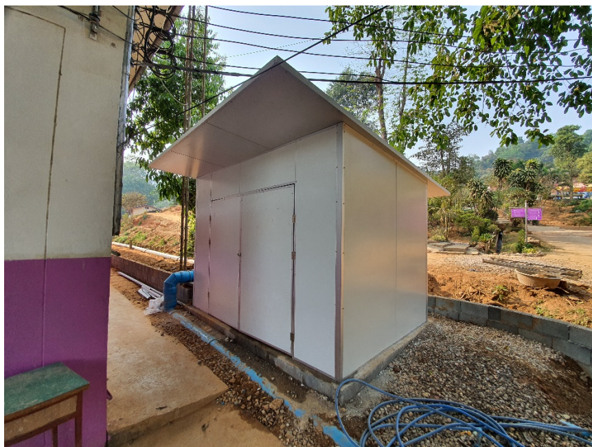
รูปผนวกที่ 16 แสดงภาพหลังก่อสร้างห้องกำเนิดไฟฟ้า
