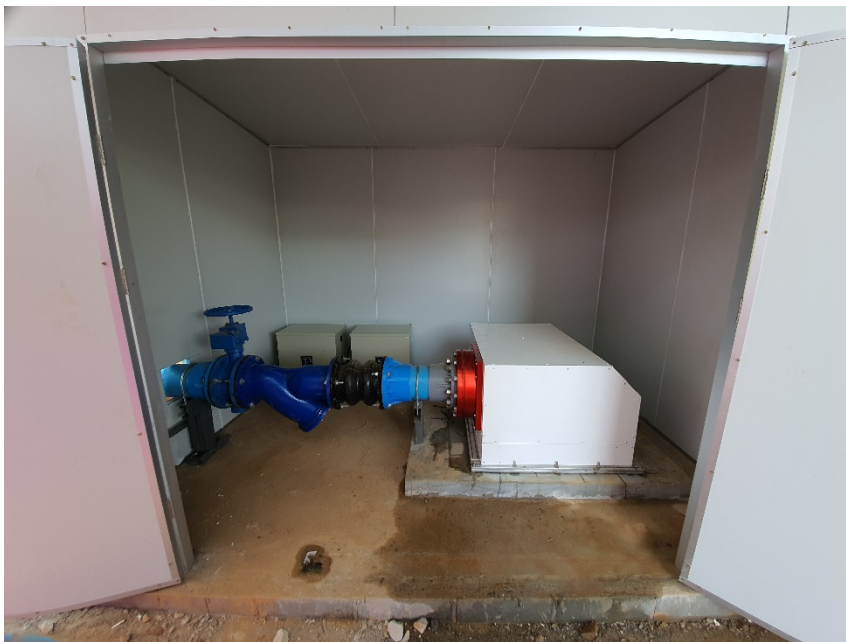
รูปผนวกที่ 18 แสดงการติดตั้งเครื่องกำเนิดไฟฟ้า
