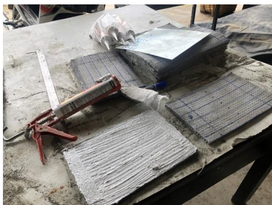
รูปผนวกที่ ก5 ทำการเชื่อมตัวประสานด้วยซิลิโคน ลงบนแผ่นผ้าใบคอนกรีต
