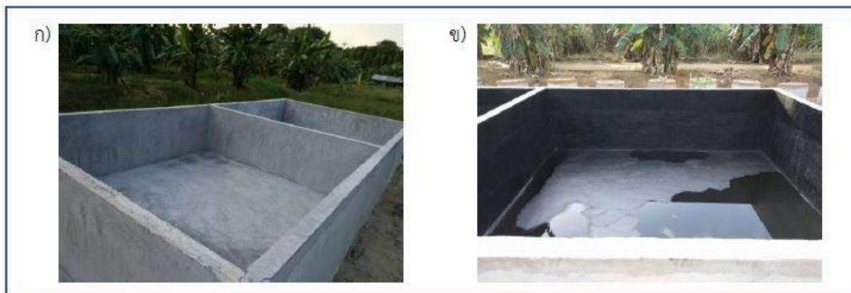
ภาพที่ 4 การปรับปรุงบ่อซีเมนต์
